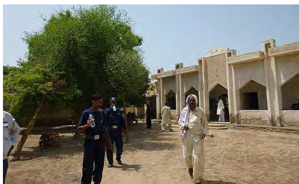
Kh02 GGPS Hadi Bux Laghari: 既存校舎(撤去予定)正面。
