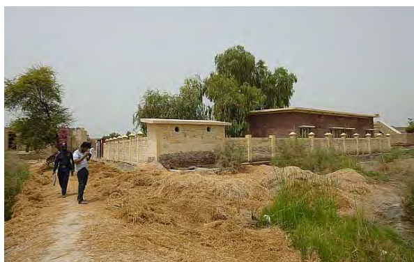
同左: 接道部分と右手前へ約4mの敷地拡張が必要。
