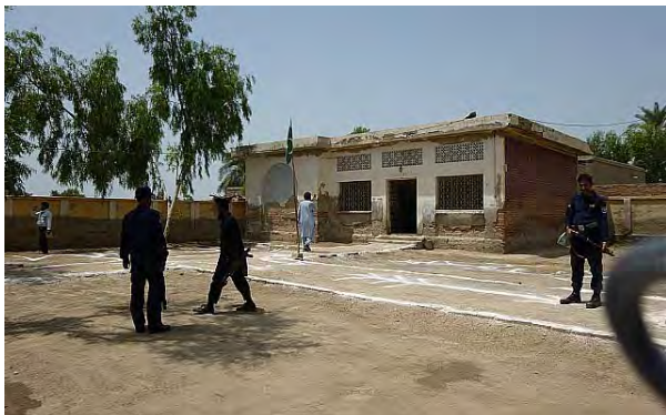
Su04 GGPS Moto Mirbahar: 既存校舎外観。
