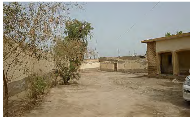
同左: 既存校敷地内の建設予定地。
