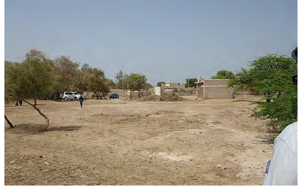
同左: 建設用地。隣接の未利用地を拡張用地として利用。
