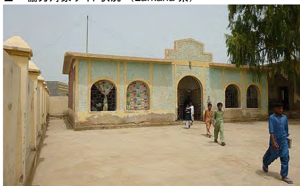
La01 GGPS Gund: 既存校舎外観。
