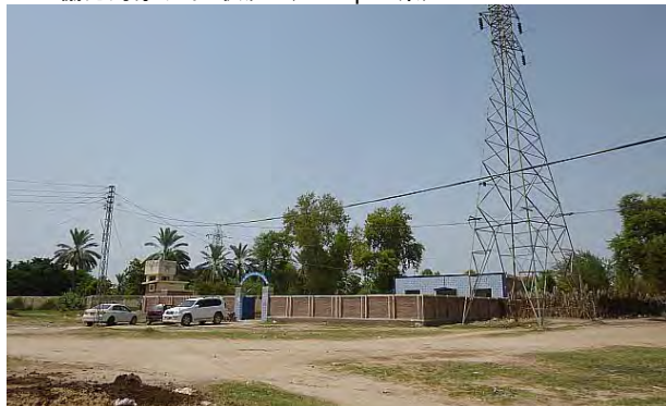
Kh01 GGPS Wapda Colony: 塀で囲われた既存校舎外観。
