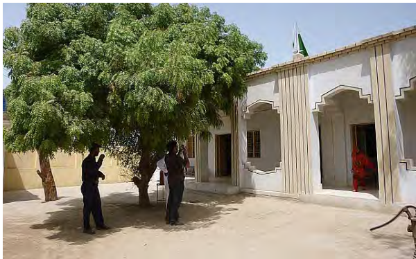
Da03 GGPS Aminani: 既存校校舎。2012年時点は建設中であった。
