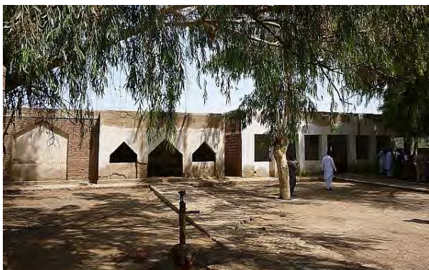
Kh08 GGPS Gambal Shah: 既存校舎外観。左手建物は危険なため使用されておらず撤去を予定する。
