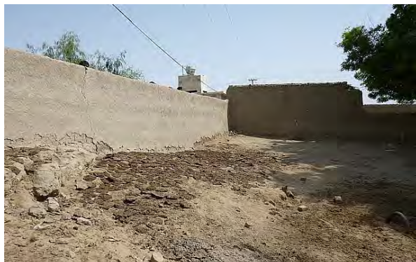
同左: 建設用地。土壁で囲われた拡張用地を利用の予定。
