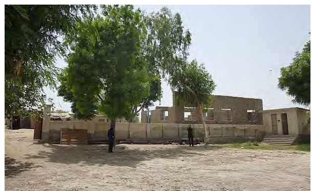
同左: 既存校敷地内の建設予定地。
