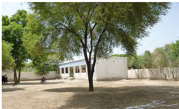
Kh05 GGPS Bajeed Fakir: 既存校舎外観。
