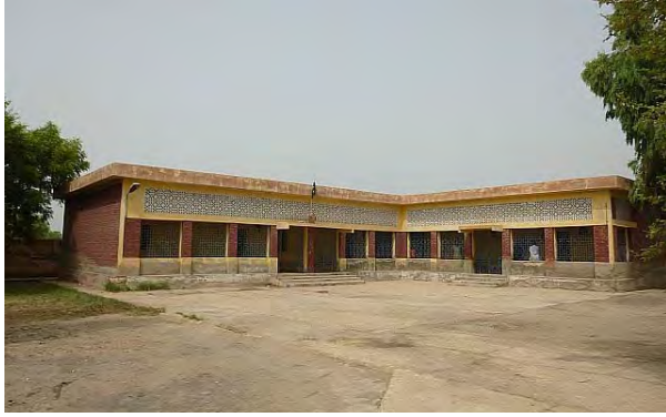
La03 GGPS Model Community Tharecha: 既存校舎外観。劣化により危険なため撤去の予定。
