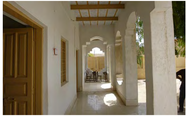
2014年竣工の新教室棟、ベランダ部分。(Da05)
