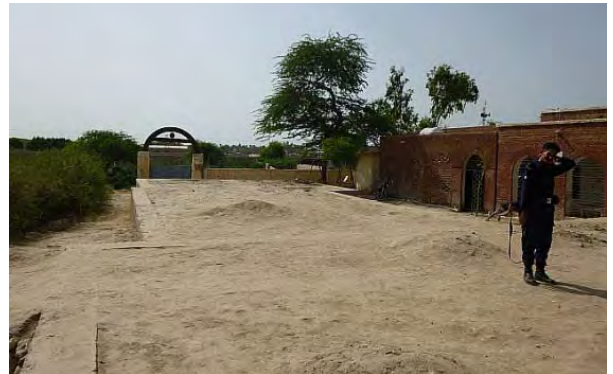
同左: 建設用地。建設途中で放置された石積み基礎が占有している。
