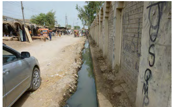
集落内の主要道路沿いに開渠が整備されている。(Da04)
