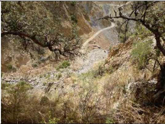
集水域での砂防施設
