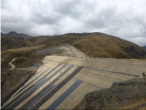
建設中のミシクニダム
