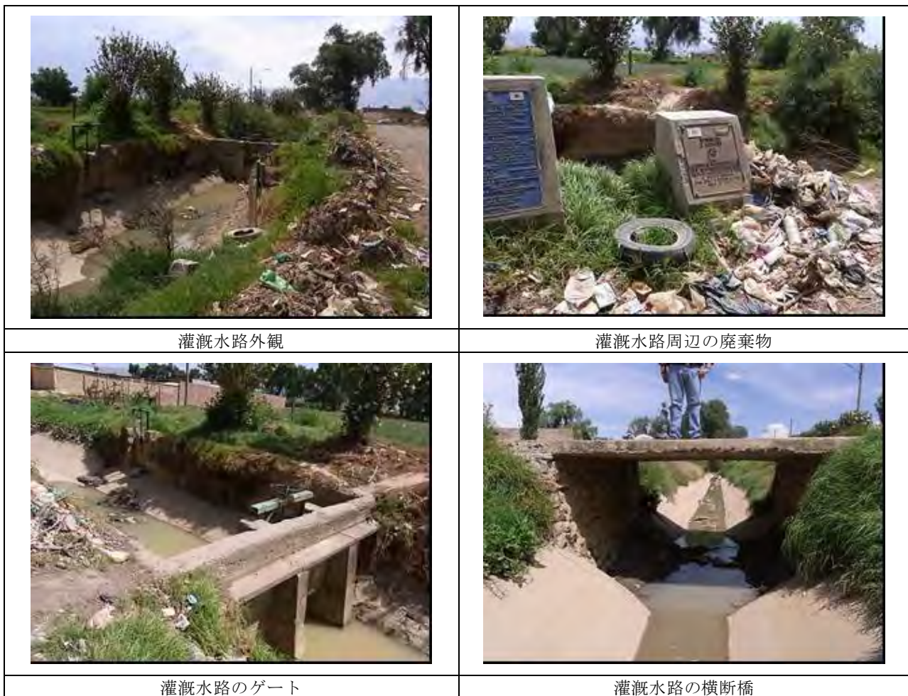
図 4-6-10 灌漑水路（マイカ地域）の様子
