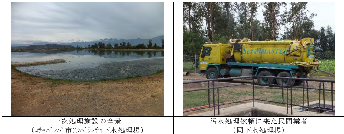
図 4-5-5 アルバランチョ下水道処理場
