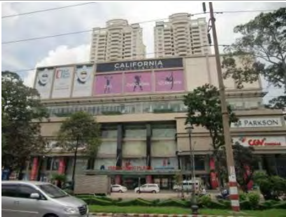
Hung Vuong Plaza 正面（背後は住居棟）
