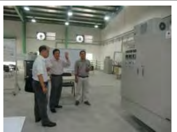
Pump 制御盤の説明
