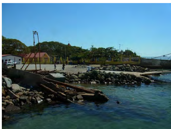
フェリーターミナル建設予定地
