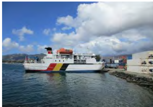
東側斜路遠景 (写真中央。コンテナに囲まれている)
