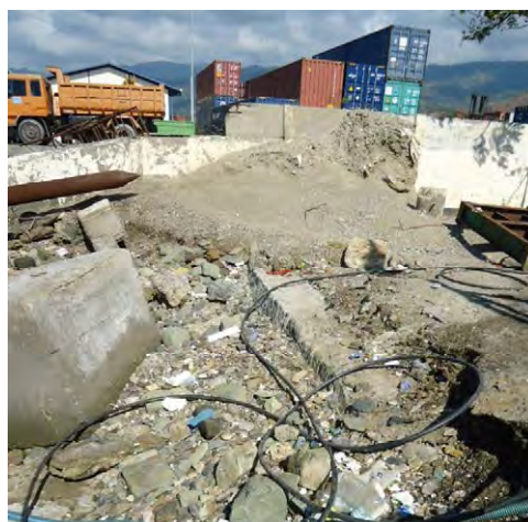
計画地点の既設護岸の状況
