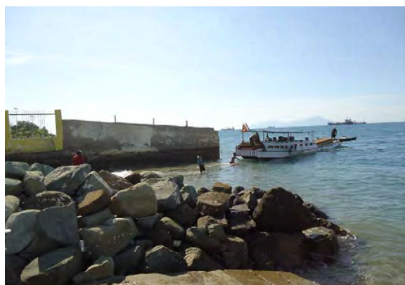
隣接公園との境界壁の状況
