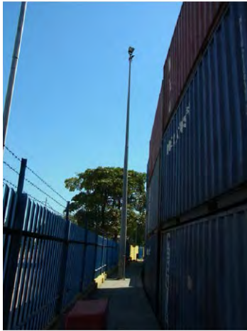
東側ゲート付近。旅客はこの通路を 通ってフェリーに乗降する。
