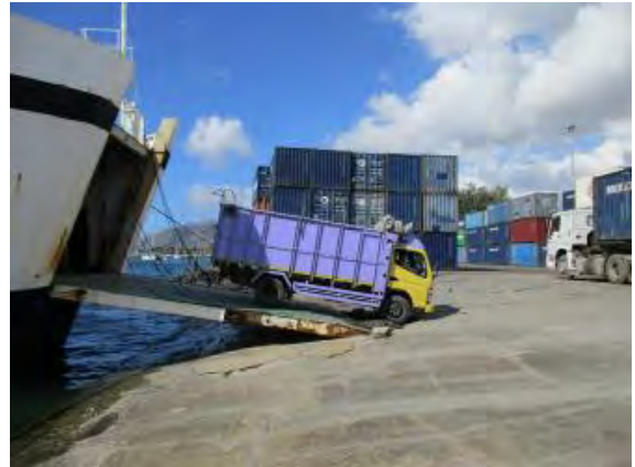
東側斜路での車両乗降状況（斜路端部構造による 接岸距離不足で開扉部と斜路設置部が鋭角とな り、車体が擦りそうな状況）
