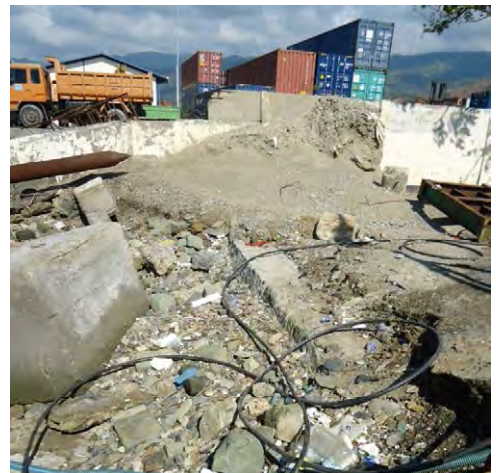
計画地点の既設護岸の状況
