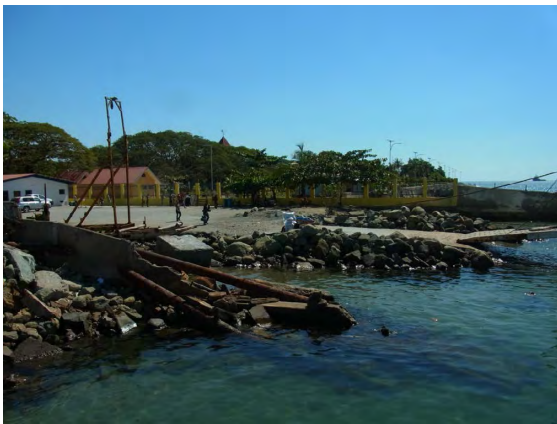
フェリーターミナル建設予定地
