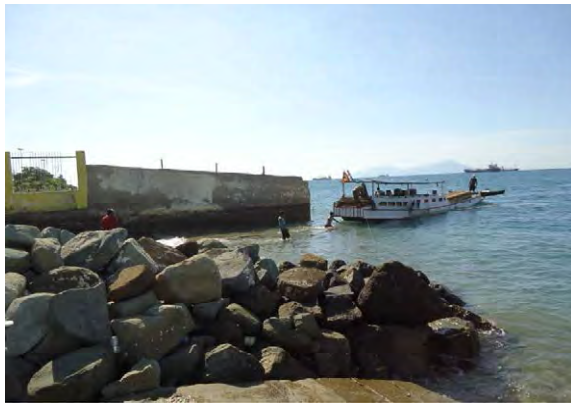
隣接公園との境界壁の状況
