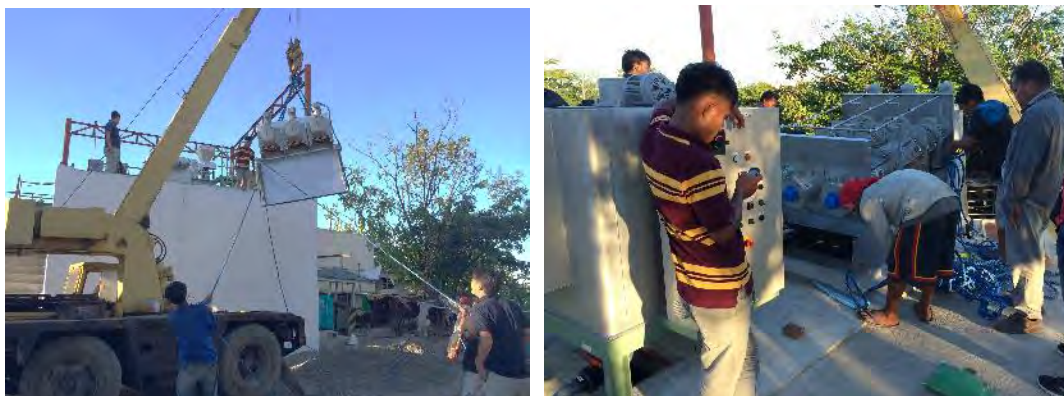
図 8：脱水機設置の様子
