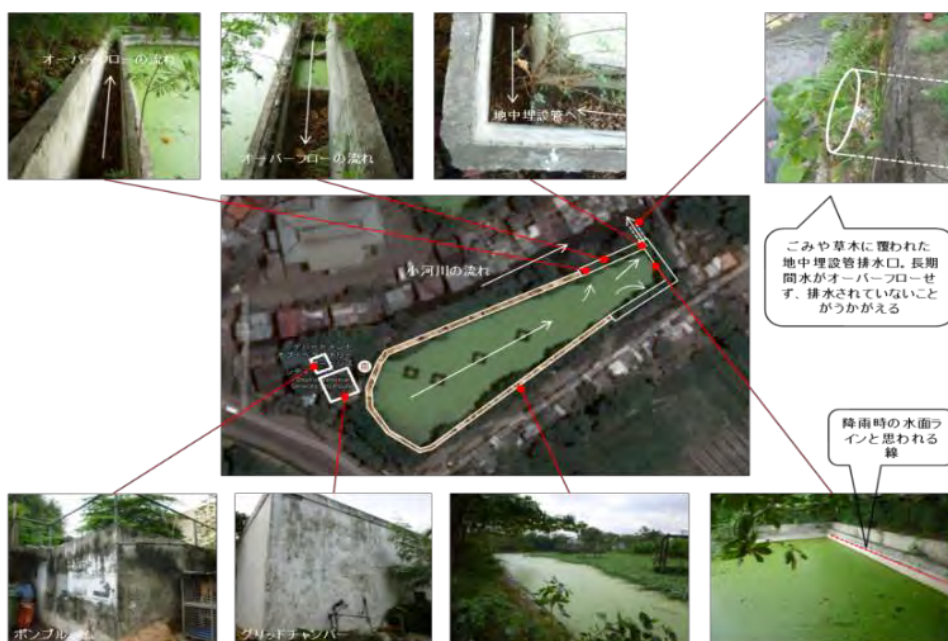
図 47：既存下水処理場の現状
