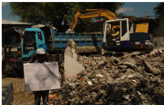
パイロットセプテッジ処理施設建設工事の様子
