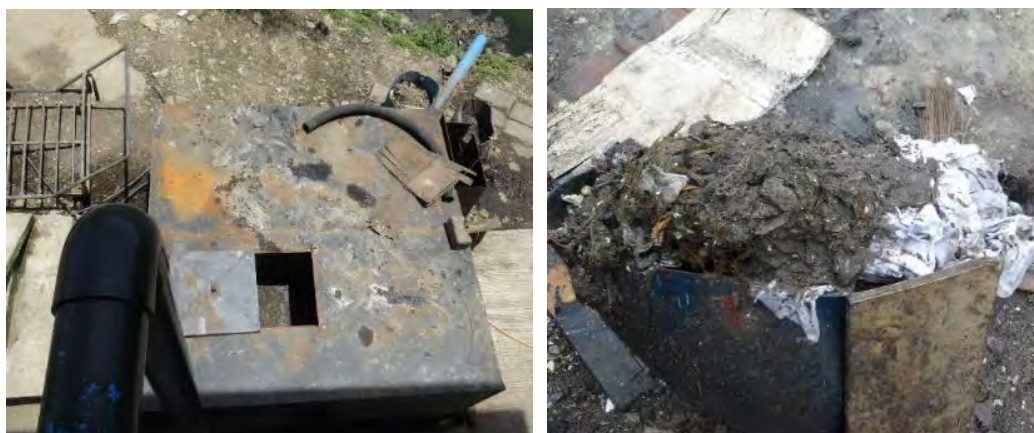
図 11：一時的に設置されたタンクと除去された夾雑物
