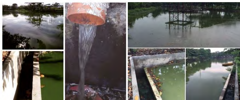
図：実証期間中のラグーン・排水口の様子
