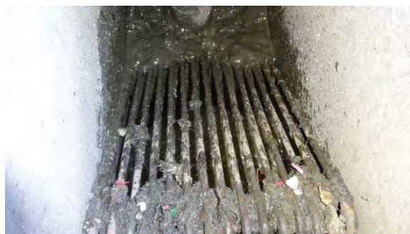
図 15：目地が粗いものに交換されたスクリーン
