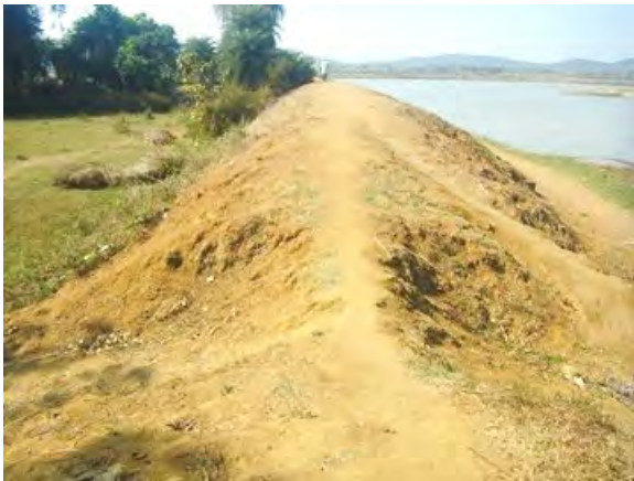
小規模灌漑地区のため池堤体。機能が低下した取水口、余水吐、水路と合わせて改修が必要である。(Vizianagaram 県)
