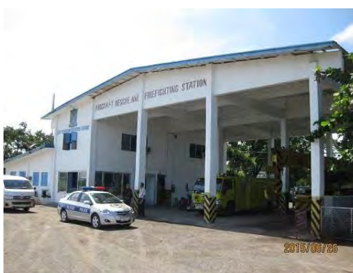
写真 救難及び消防施設
