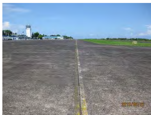
写真 エプロン誘導路
