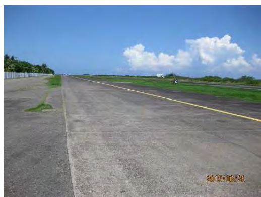
写真 平行誘導路
