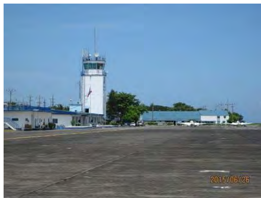
写真 エアサイドから見た管制塔
