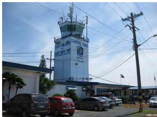
写真 ランドサイドから見た管制塔
