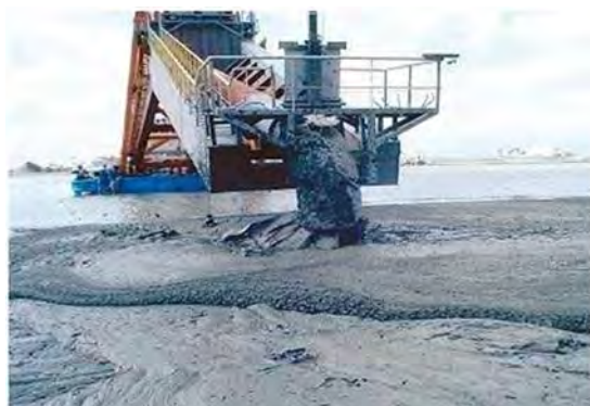
写真 8.6-4 セメント混合で改良された粘土
