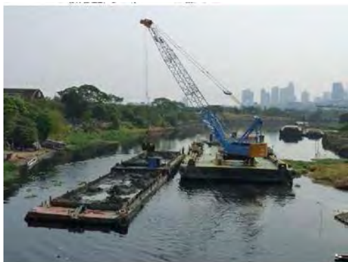
写真 8.6-3 クラムシェルグラブによる浚渫
