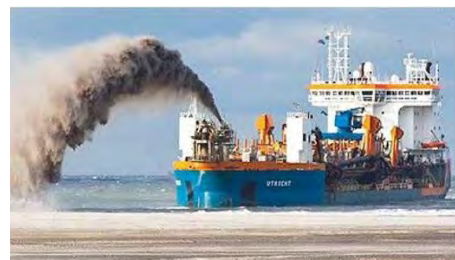
写真 8.6-2 TSHD による吹き上げ工
