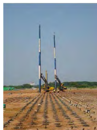
写真 8.6-5 PVD の陸上打設風景
