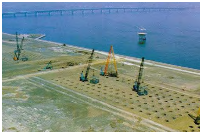
写真 8.2.7 関西空港での施工状況
