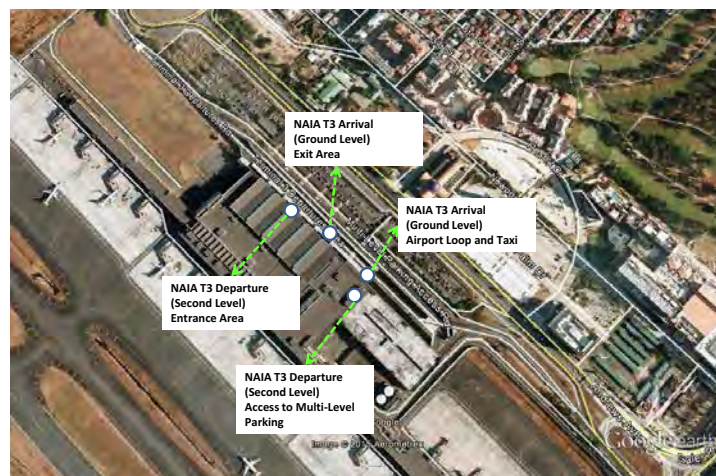
ターミナル3の調査箇所(3)
