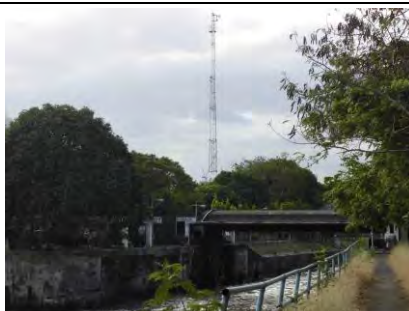
Napindan HCS に建設された鉄塔
