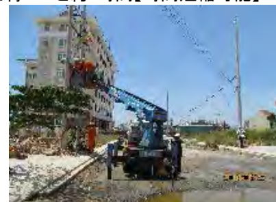
変圧器の撤去→新しい変圧器到着まで待つこと約2時間【時間短縮可能】
