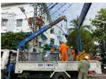
バケットを外しクレーンをセット
