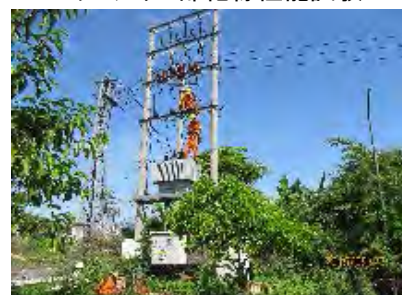
カットアウト部絶縁性能試験
