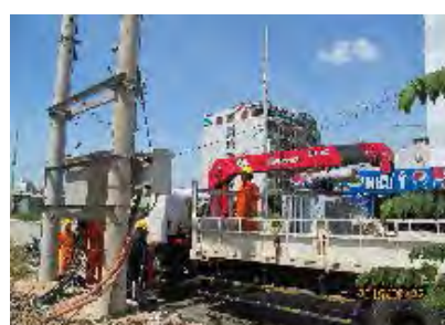
変圧器の撤去→新しい変圧器到着まで待つこと約2時間【時間短縮可能】
