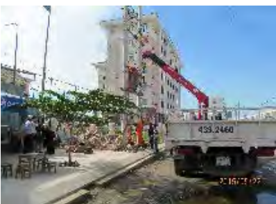
変圧器の撤去→新しい変圧器到着まで待つこと約2時間【時間短縮可能】
