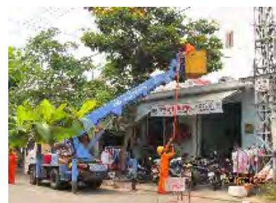
高所作業車よりHot stickを用い、作業実施。高所作業車はアイチ製。
