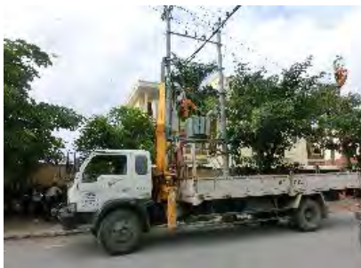
22kV用変圧器
