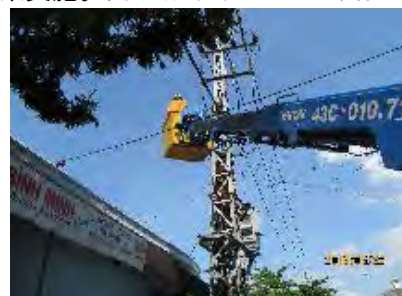
カットアウト部絶縁性能試験
