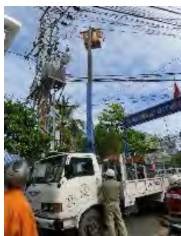
バケット内より本線カットアウト取り外し
