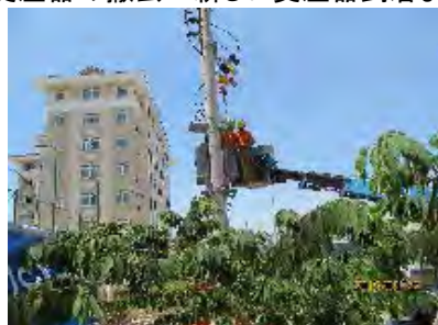
変圧器の撤去→新しい変圧器到着まで待つこと約2時間【時間短縮可能】
