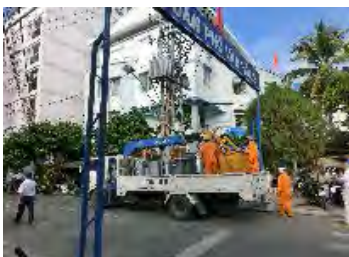
クレーン先端部へバケット取付け
