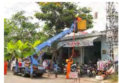
高所作業車よりHot stickを用い、作業実施。高所作業車はアイチ製。
