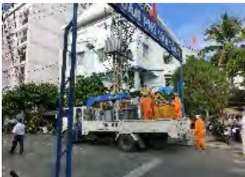
クレーン先端部へバケット取付け
