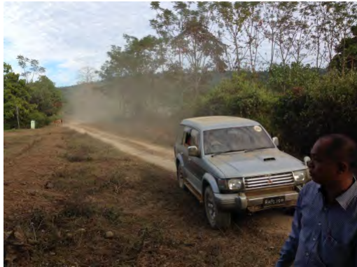
農村部での道路状況 (未舗装のため雨期の交通が困難)
