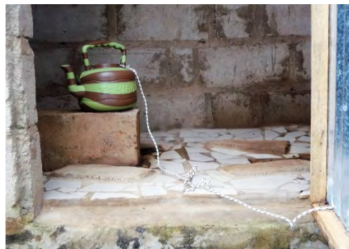
上屋つきトイレ、使用しない穴は蓋をする
