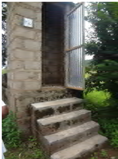
ケドッグに建設された高床式トイレ
