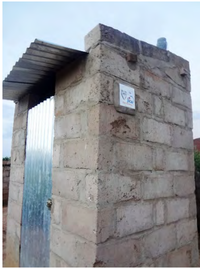
プロジェクトで設置されたトイレ
