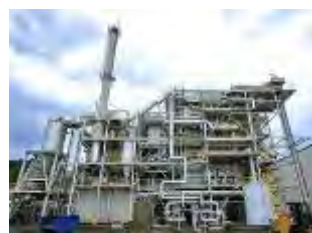
白河ウッドパワー(株) 木質バイオマス発電施設 (出力 11,500kWh)
