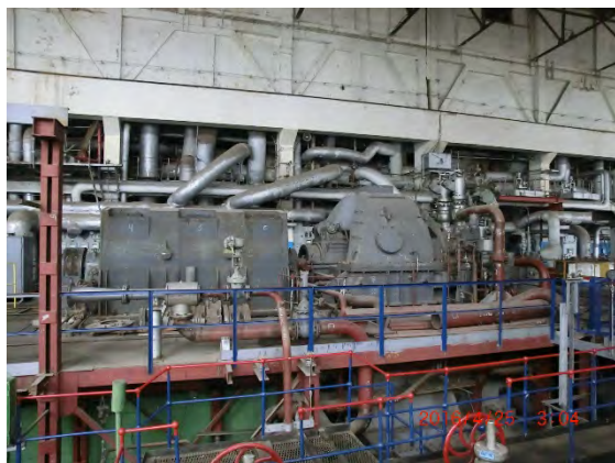
(据付途中の Turboatom 製復水タービン)
