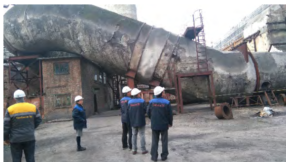
（ボイラ煙突間の煙道）
