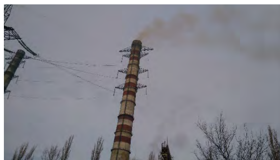
（煙突（曇り空に有色ばい煙を確認））
