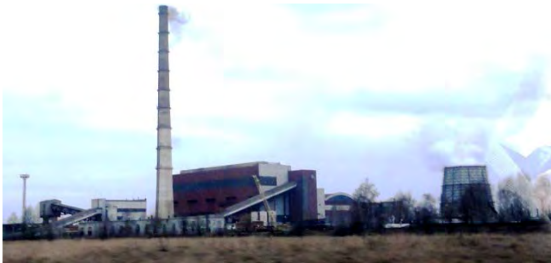
(クルスカ CHP の外観 (現在、No. 2 のみ運転中、No. 1 点検中、No. 3/4 停止中))
