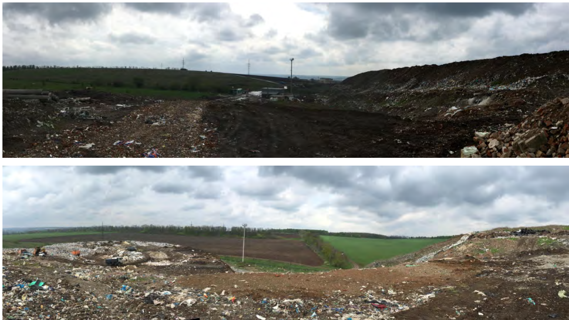
図 8.3-1 Dergachi 埋立処分場の状況
