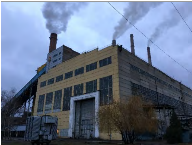
図 5.2-11 煙突からの排出状況（有色ばい煙を確認）
