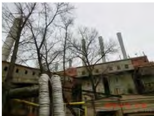
図 7.3-1 Kyivenergo CT-1 の外観
