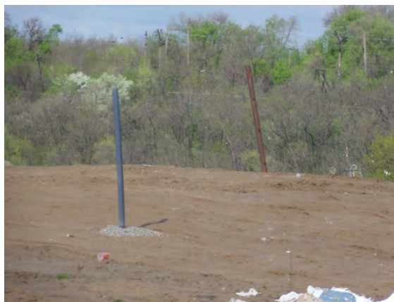
(発生メタンガス収集配管)
