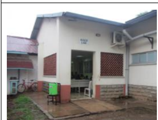
検査室入口への設置状況
