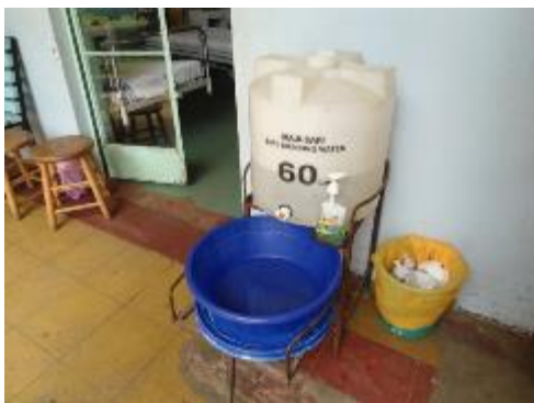
水栓が老朽化している病棟で水が使用できないところに設置された手洗い用水栓付タンク
