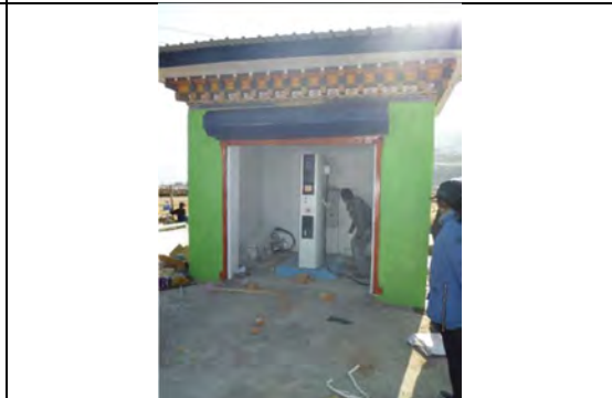
写真-22 : Paro での QC 設置状況
