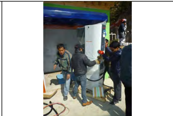
写真-18 : Chunzom での QC 設置状況
