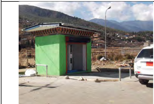
写真-23 : Paro での QC 設置後の状況
