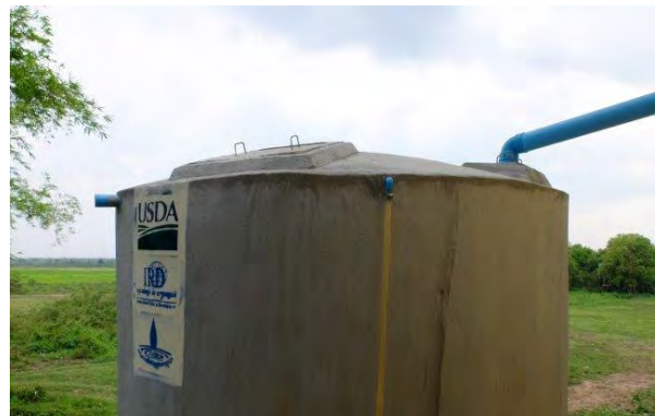
カンボジア： 雨水をろ過し、生活用水として利用している
