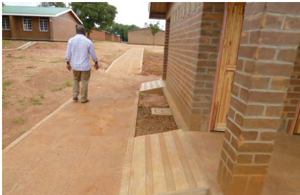
マラウイ： 外構スロープから繋がる便所へのアプローチスロープ
