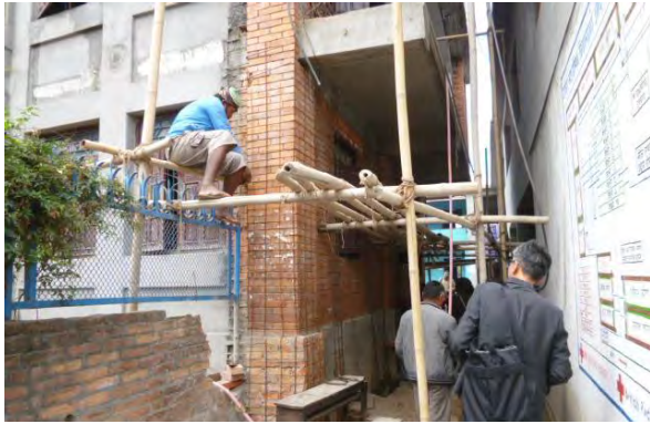
ネパール： 既存建物耐震補強工事(国家政策) 鉄筋補強工事
