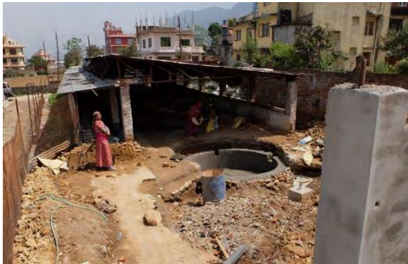
ネパール： 便所からの人の排出物を利用したバイオガス ダイジェスター。写真中央は液肥排出口
