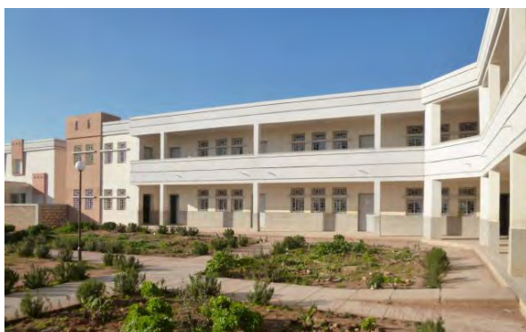
他ドナー財政支援型: Boulaouane コミュン Alfadila 中学校 (PU により建設)
