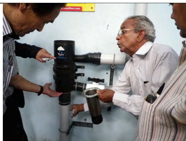
写真 3. 現地で使用されている雨水集水システム。現地で”Rainwater Harvesting”の普及活動を長年取り組んでいる NGO で説明をうける。
