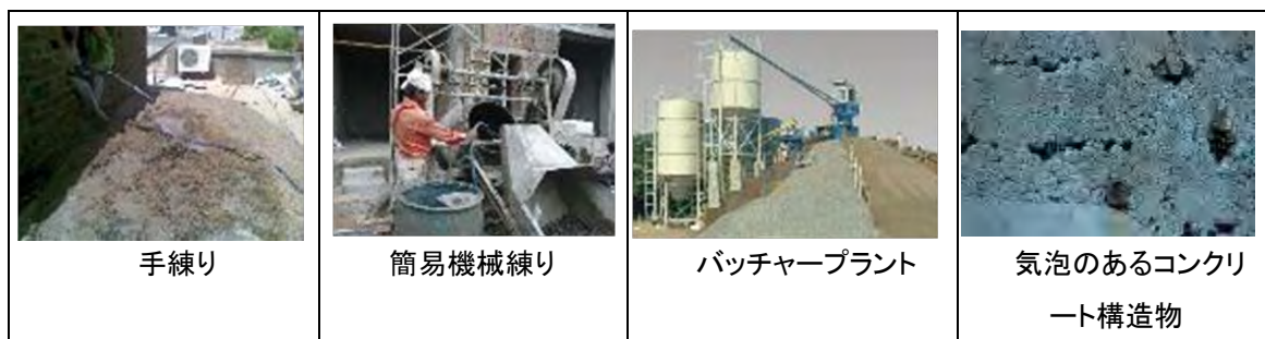
図 2-1 インドにおけるコンクリート製品製造現場
