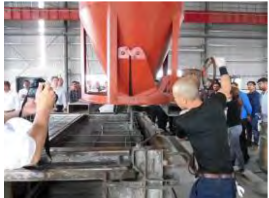
生コン投入デモンストレーション
