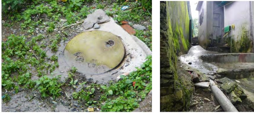
**図 1-14 東側斜面住居エリアの越溢しているマンホール及び路上洗濯の状況**
