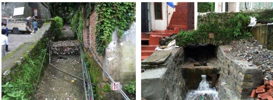
図 1-13 東側斜面住居エリアの雨水排水路とごみ止めネットおよび排水状況
