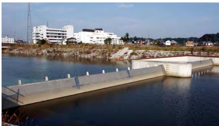
写真 5.11 鋼製起伏堰設置例
