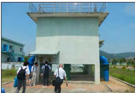
写真 3.6 San Bay 浄水場の着水井。Cau Do 浄水場の着水井から原水がここまで送水されている。
