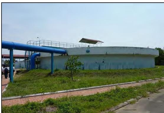
写真 3.8 San Bay 浄水場の高速凝集沈殿池
