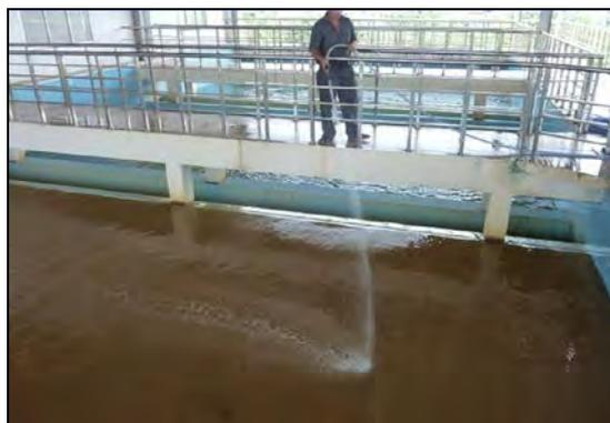
写真 3.7 急速ろ過池。定期的にワーカーがホースから水を噴射して洗浄時のスカムの除去を行っている。
