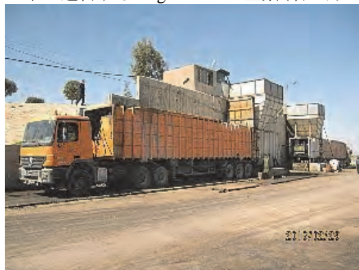
2 基の圧縮装置付きホッパーによる積み替え作業
