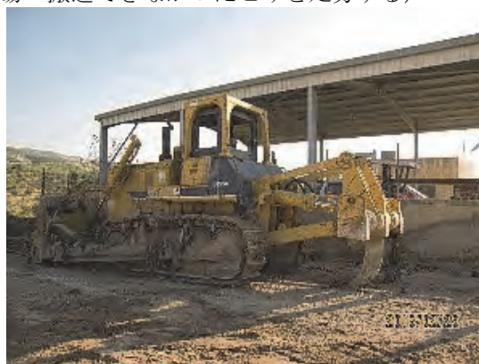
埋立用ブルドーザ (日本より供与)
