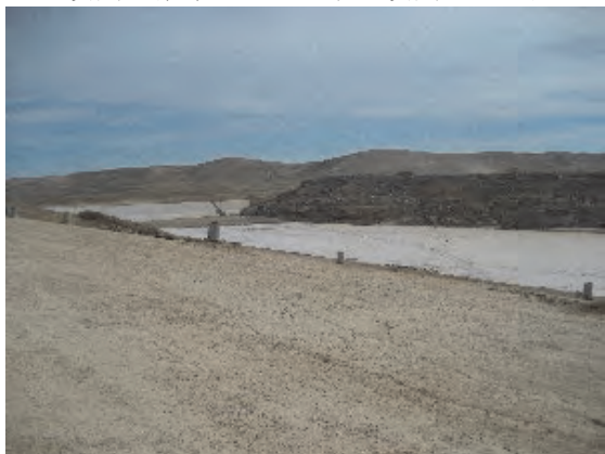
現在の埋立地 (Cell 4) 遮水工が施工されている
