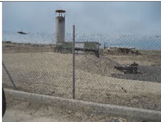
Landfill Gas の燃焼施設
