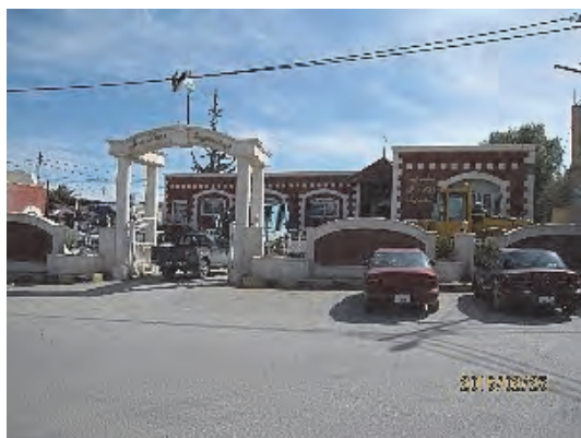
Azraq 市役所、敷地内に機材を駐機させている。
