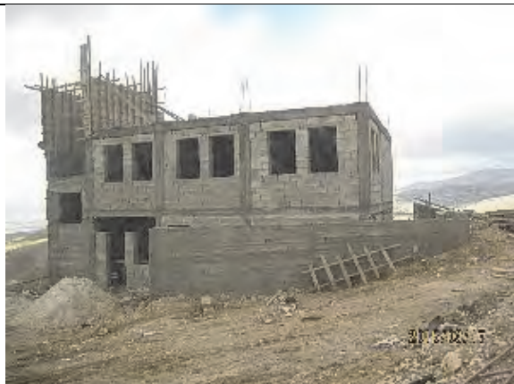
環境省が建設中の管理棟。
