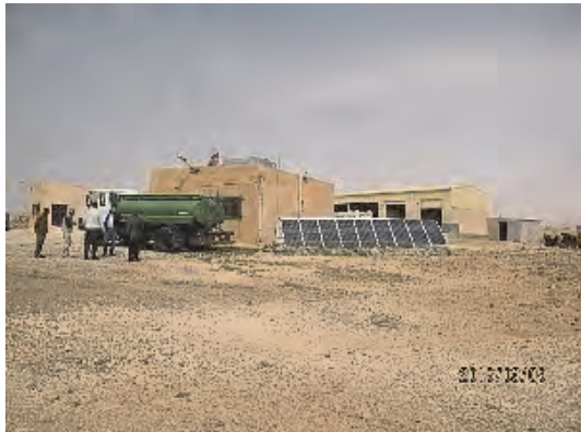
Northern Badiah 処分場の管理施設
