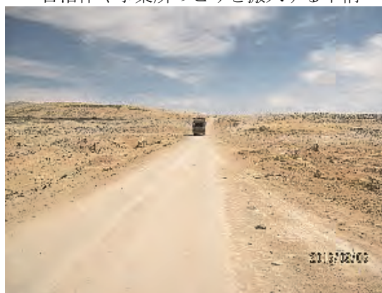
埋立区画への場内道路
