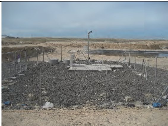
浸出水循環用ポンプ場と浸出水処理池
