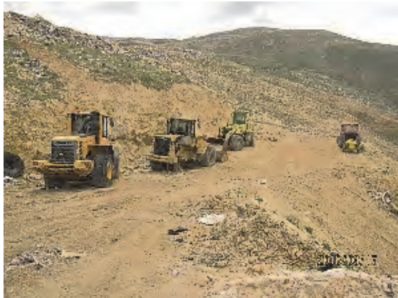
比較的新しい埋立用機材であるが、修理が為されずに放置されている。
