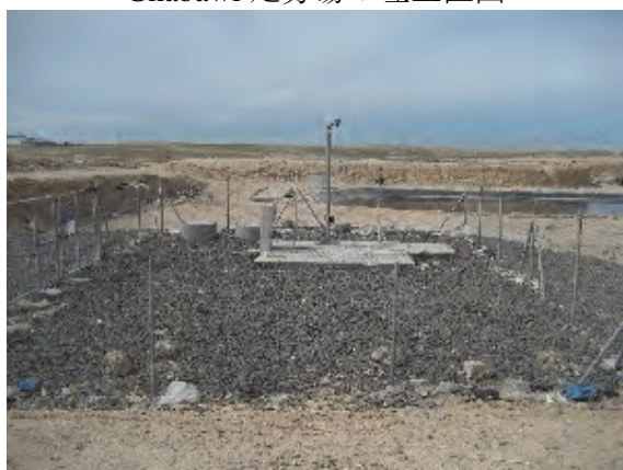
浸出水循環施設 (Ghabawi 処分場)
