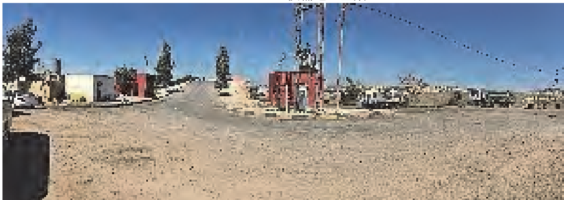
Irbid 市が運営する Togbul T/S の全景 (右上方で収集車が荷下ろし、右下側でトレーラーに積み込む)
