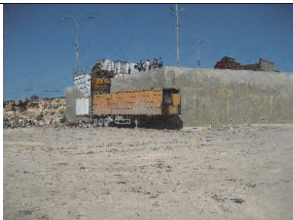
圧縮装置付きホッパーでコンテナに積み替えている
