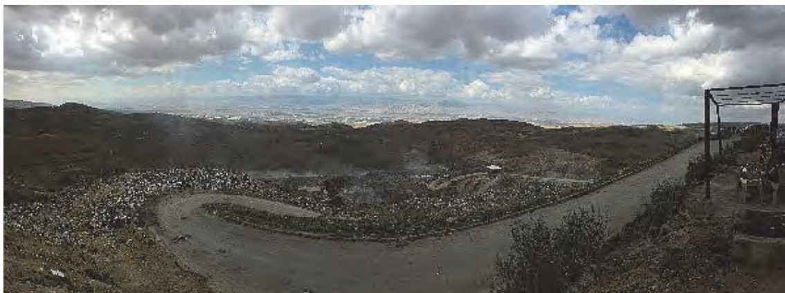
Al Humra 処分場の全景（場内道路が急峻であるため、雨や雪で侵入できない場合には沿道に投棄している。これらのごみが自然発火し、煙が日常的に立ちこめている。遠方の平野はヨルダン溪谷）
