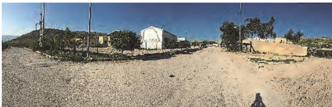
Aghwar 中継基地の全景 (左に T/S、中央奥に処分場、右に事務所及び駐機場がある)
