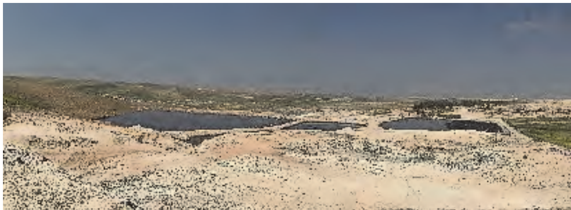
Al Ekaider 処分場におけるオリーブ油製造廃水 (Zibar) 処理池
