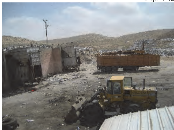
壊れた圧縮装置とトレーラー
