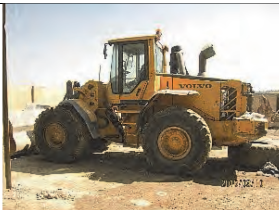
埋立作業の主役となっているホイールローダ
