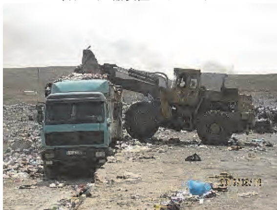
Open top trailer に積載したごみを圧縮する Wheel Loader
