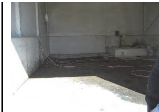
Biogas Plant の受け入れ施設
