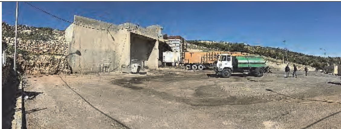
積み替え施設（圧縮装置付きホッパーは1基）
