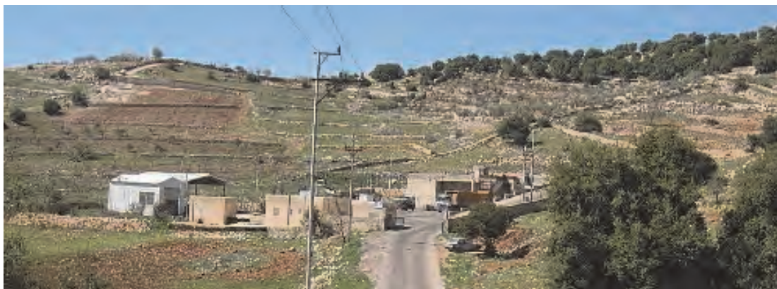
Ajloun TS の全景 (正面が管理棟、左が部品庫と駐機場、右に積み替え施設)
