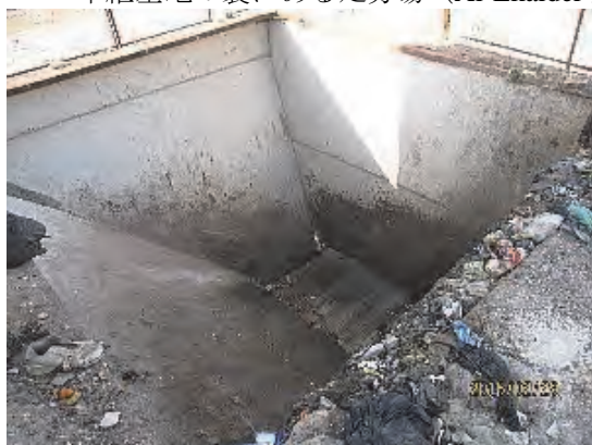
圧縮装置付きホッパー (下にトレーラがある)
