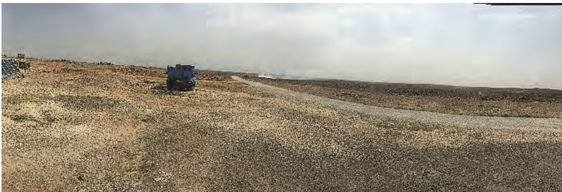
管理棟から見た処分場の全景
