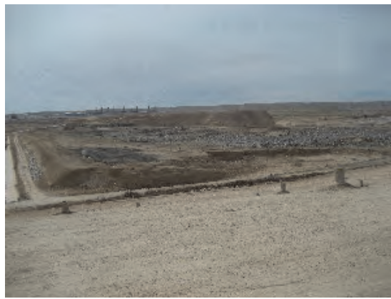
次期埋立地 (Cell 5)、大雨で Cell 4 に入れない期間ごみが投棄された。
