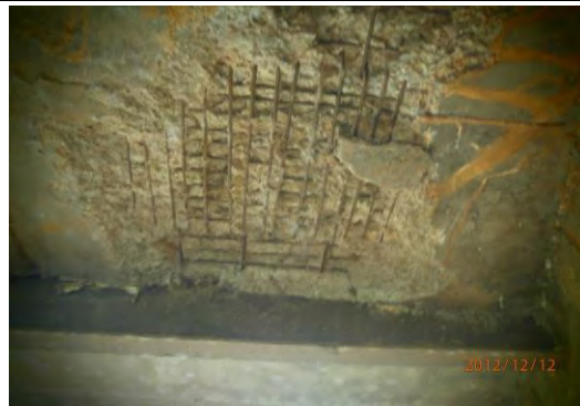
写真 C-14 橋梁 No.10 (床版下部) (2015年10月)
