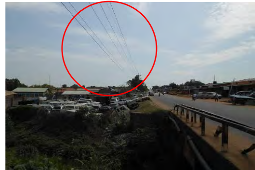
No.1 橋 移設対象の架空電線
