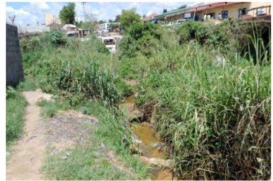
写真 C-4 橋梁 No.1 (河川状況／上流を臨む) (2015年10月)
