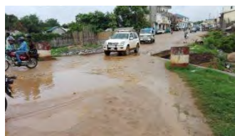
写真 1-3-2(2) 橋梁 No.4 周辺
