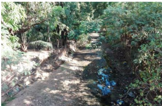
写真 C-11 橋梁 No.7 (河川状況／下流側を臨む) (2015年10月)
