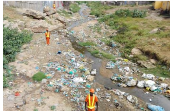
写真 C-8 橋梁 No.4 (河川状況／下流側を臨む) (2015年10月)
