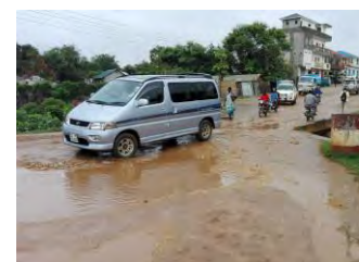
写真 1-3-1 橋梁 No.4 の現況
