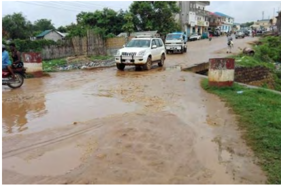
写真 C-7 橋梁 No.4 (道路状況／終点側を臨む) (2015年10月)
