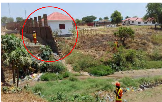
No.10 橋 ブロック擁壁撤去(仮設通路部)
