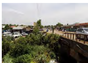
写真 1-3-2(1) 橋梁 No.1 周辺
