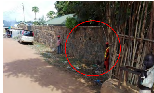
No.7 橋 石積擁壁撤去部
