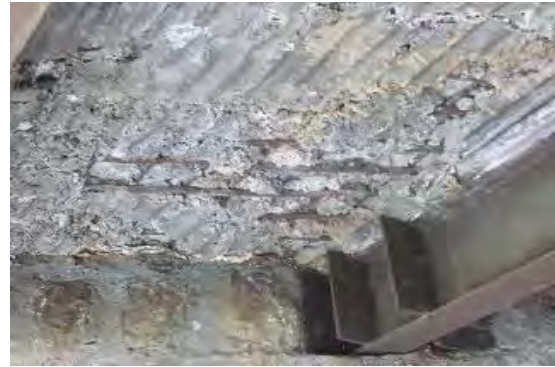
写真 C-2 橋梁 No.1 (床版下部) (2015年10月)
