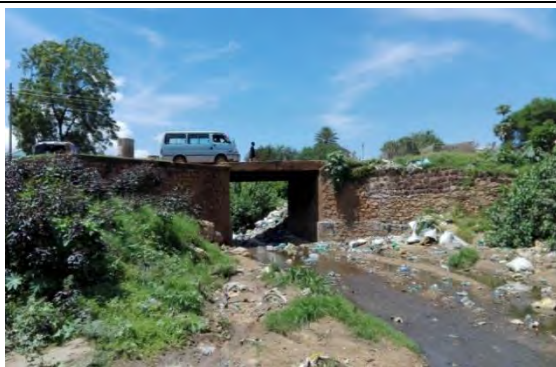
写真 C-5 橋梁 No.4 (橋梁全景／河川下流から臨む) (2015年10月)
