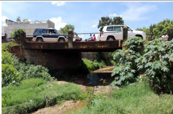
写真 C-13 橋梁 No.10 (橋梁全景／河川上流側より臨む) (2015年10月)
