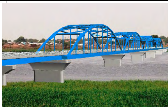
写真 C-18 ナイル架橋 (建設中)
