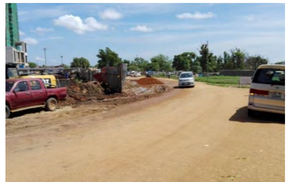
写真 C-12 橋梁 No.7 (道路状況／橋梁から終点側を臨む) (2015年10月)
