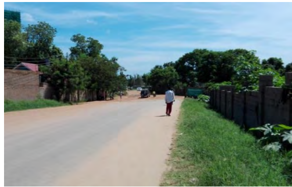
写真 C-10 橋梁 No.7 (道路状況／始点側より臨む) (2015年10月)
