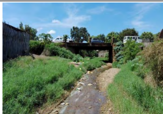
写真 C-16 橋梁 No.10 (河川状況／下流側より臨む) (2015年10月)
