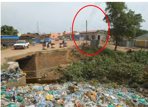
No.4 橋 移設対象の電柱と架空線
