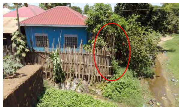
No.10 橋 竹柵撤去(河道部)
