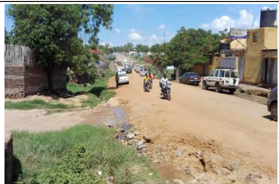
写真 C-15 橋梁 No.10 (道路状況／終点側より臨む) (2015年10月)
