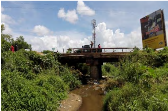
写真 C-1 橋梁 No.1 (全景／河川上流側から臨む) (2015年10月)
