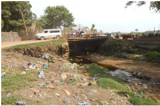
写真 C-9 橋梁 No.7 (橋梁全景／河川上流側より臨む) (2015年10月)
