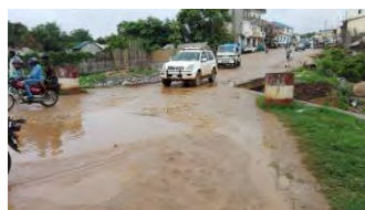
写真 1-3-2(2) 橋梁 No.4 周辺
