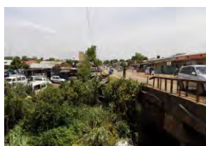
写真 1-3-2(1) 橋梁 No.1 周辺
