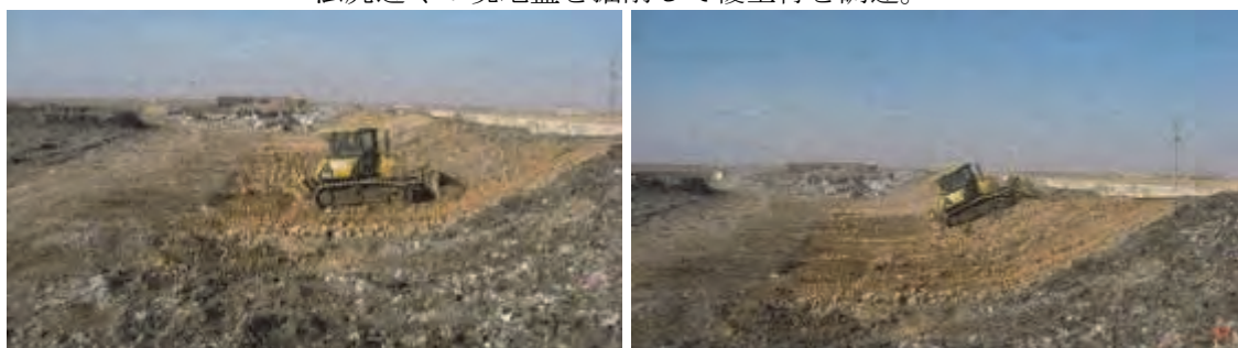
法尻近くの現地盤を掘削して覆土材を調達。
