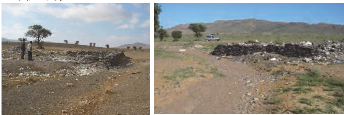
Arbah Rasmouka既存処分場。河道(wadi)近くに位置するも、流失防止のために石積みを実施している。
