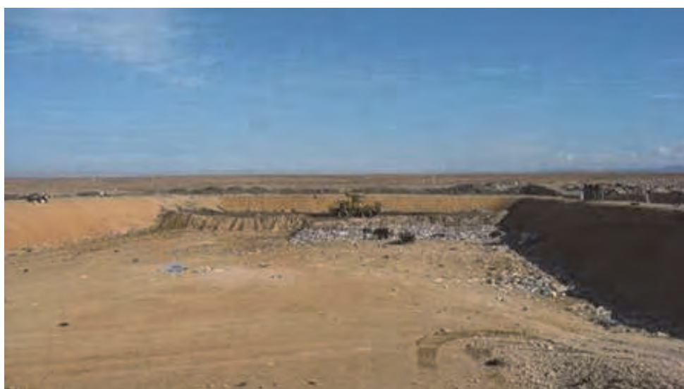
ピット奥側の埋立状況 (2014年10月撮影、11月下旬の大雨の前)
