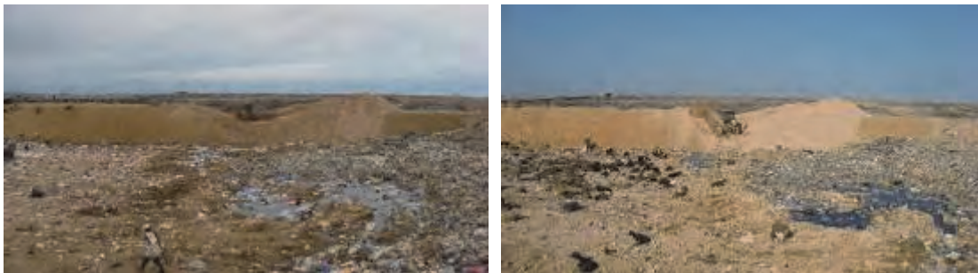
周回堰堤の一部を掘削切除を開始。
