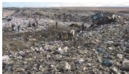
ドーザー板を用いての敷均し作業
