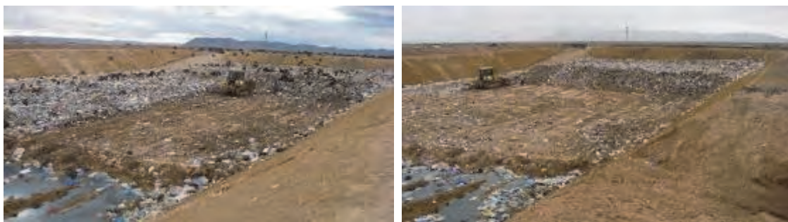
冠水していないPit手前側(入口側)の埋立状況
