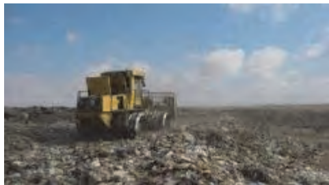
天盤を連続走行する形の転圧作業を試行。
