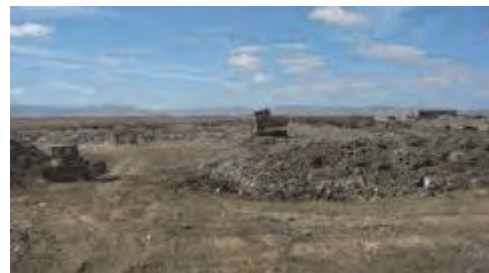
法面の天端を長手方向に連続走行する形の転圧作業を試行。
