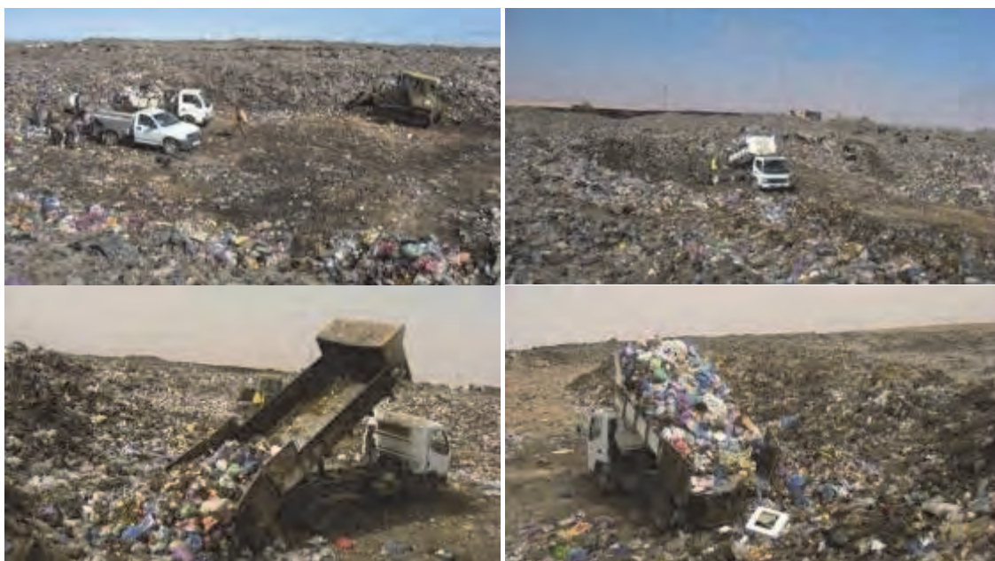
法尻近くにデイスチャージする車両と誘導するスーパーバイザーMr. Arhil Abdelhadi
