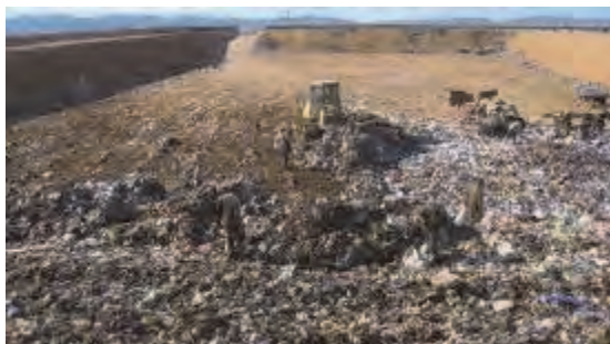
ピット奥右側エリアの敷均し作業
