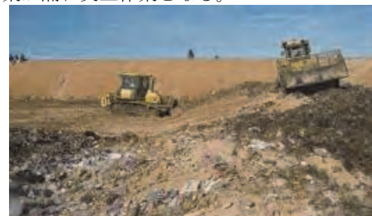
ピット奥左側エリアの転圧覆土作業
