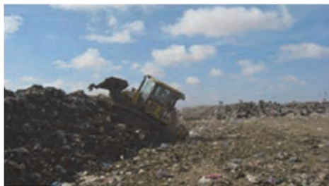
斜面の敷均し転圧
