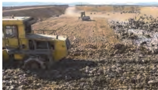
ピット内の埋立済みエリアの天盤転圧作業
