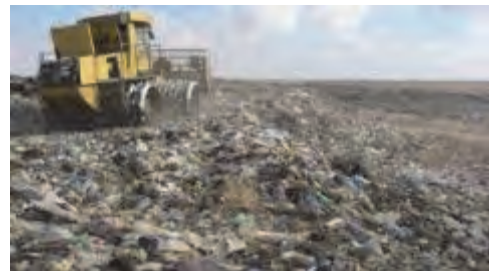
天盤を連続走行する形の転圧作業を試行。
