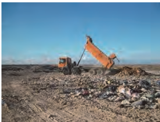
入口左側エリアの二段目天盤覆土 (市内の建設廃材や掘削土砂を持ち込んでの覆土)
