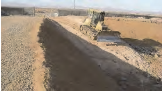
ピット内へのスロープの改修
