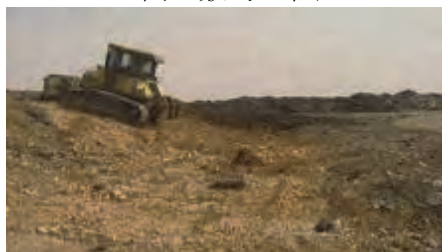
掘削材を活用した法面覆土
