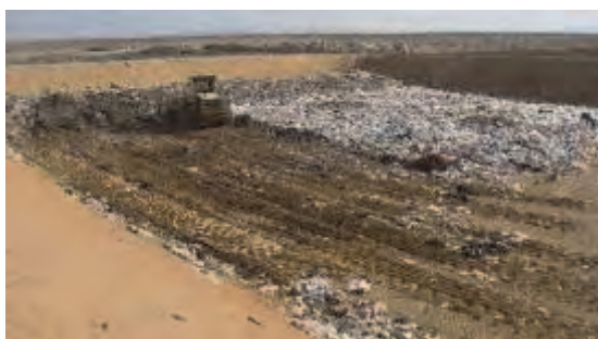
ピット奥左側エリアの敷均し作業
