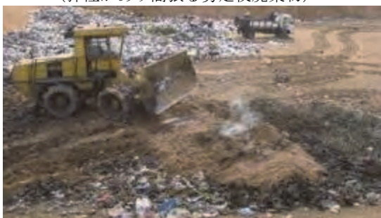
火種を含む廃棄物を隔離し覆土により消火
