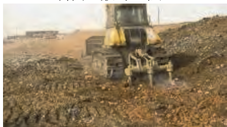
法尻現地盤の掘削
