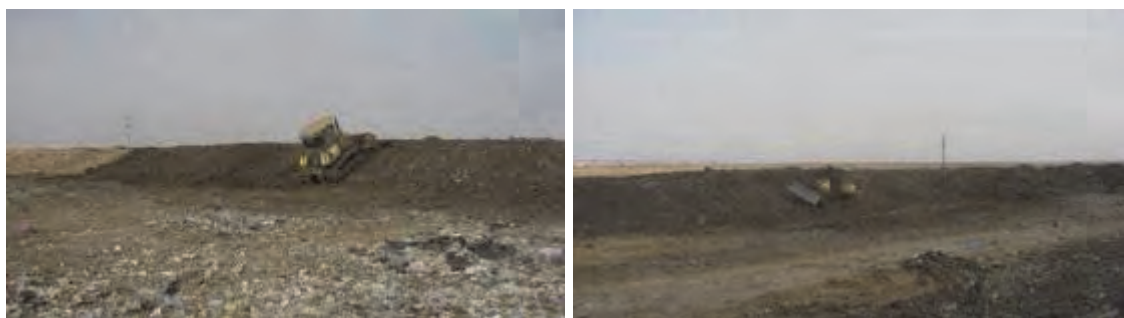
覆土前の廃棄物法面の整形と転圧
