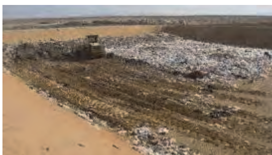
ピット奥左側エリアの敷均し作業
