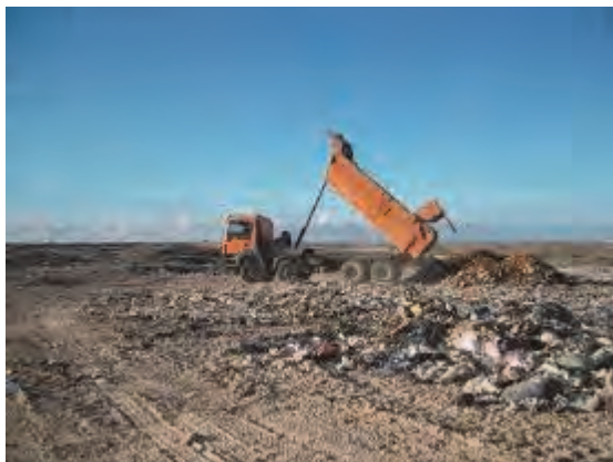
入口左側エリアの二段目天盤覆土（市内の建設廃材や掘削土砂を持ち込んでの覆土）
