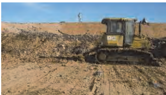
法尻現地盤の掘削と掘削土の覆土利用
