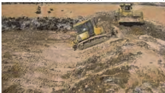
ピット奥右側エリアの転圧覆土作業 上の2図が隔日交互作業となる。
