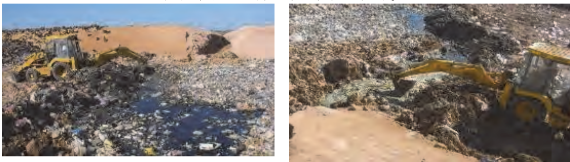
堰堤の一部を掘削除去し湛水排除を開始。その後、湛水エリアを順次狭める。
