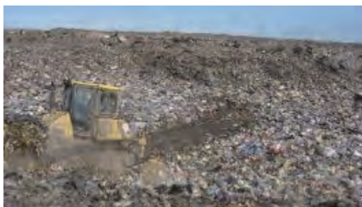
ドーザー板を用いての敷均し作業
