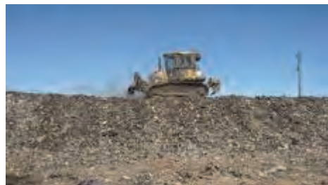
上面の敷均し転圧
