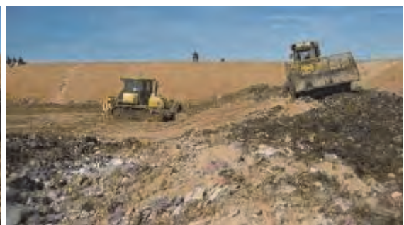
法尻現地盤の掘削と掘削土の覆土利用
