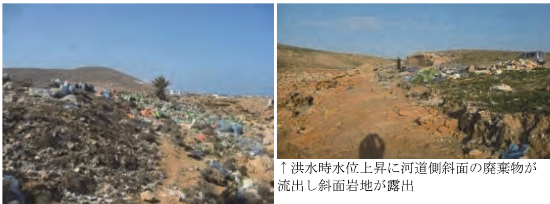
写真中央の樹木は2014年11月洪水時の水位上昇により流出。（下流側方向を撮影20013年9月） ↑洪水時水位上昇に河道側斜面の廃棄物が流出し斜面岩地が露出 ↑左写真の樹木辺りの位置より上流側の窪地方向を撮影（2015年1月）
