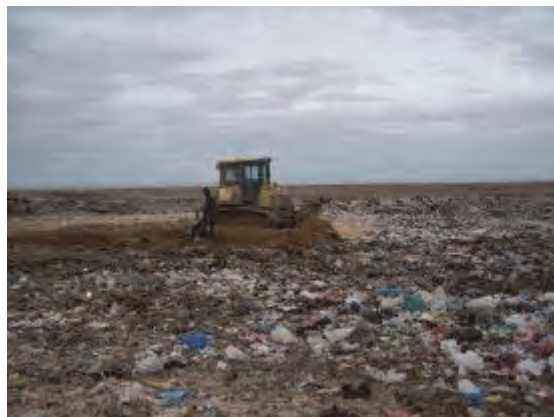
入口左側エリアの二段目天盤覆土（市内の建設廃材や掘削土砂を持ち込んでの覆土）
