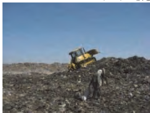
ドーザー板を上げてクローラ(履帯)による転圧作業
