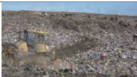
ドーザー板を用いての敷均し作業
