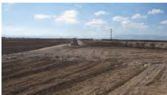
入口手前側エリアの一段目の天盤覆土の大半が完了 (奥側から入口方向を見る。) (入口から堰堤除去部方向を見る)
