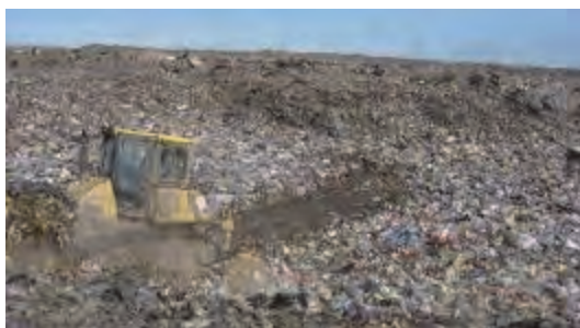
ドーザー板を用いての敷均し作業
