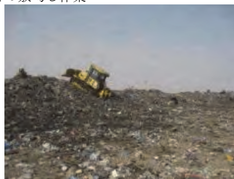
ドーザー板を上げてクローラ(履帯)による転圧作業
