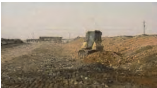
道路側溝の掘削施工（直線部）
