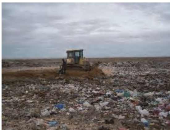
入口左側エリアの二段目天盤覆土 (市内の建設廃材や掘削土砂を持ち込んでの覆土)
