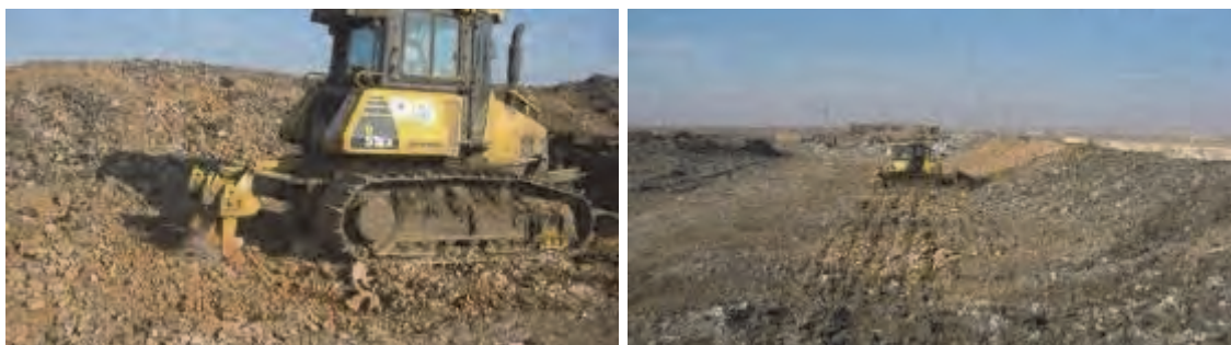
法尻近くの現地盤を掘削して覆土材を調達。
