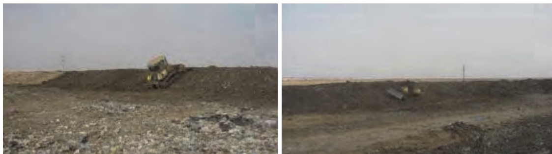
覆土前の廃棄物法面の整形と転圧
