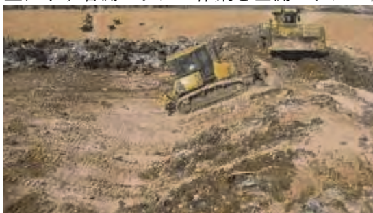
ピット奥右側エリアの転圧覆土作業 上の2図が隔日交互作業となる。
