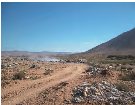
右岸上面上の進入路
