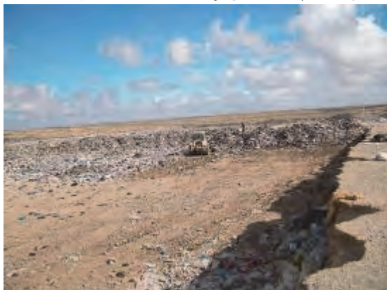
奥側の二段目埋立状況2015年10月中旬 (入口から奥エリア見る。)
