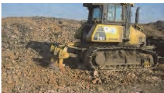
法尻近くの現地盤を掘削して覆土材を調達
