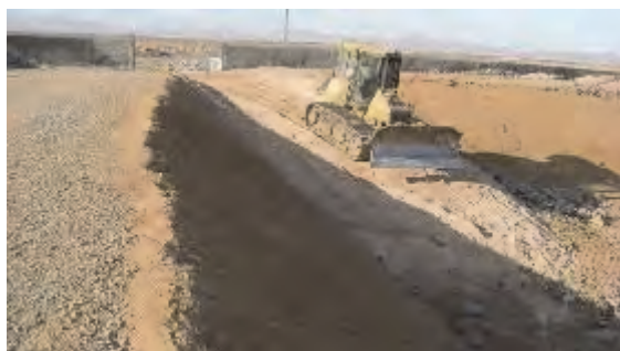
ピット内へのスロープの改修
