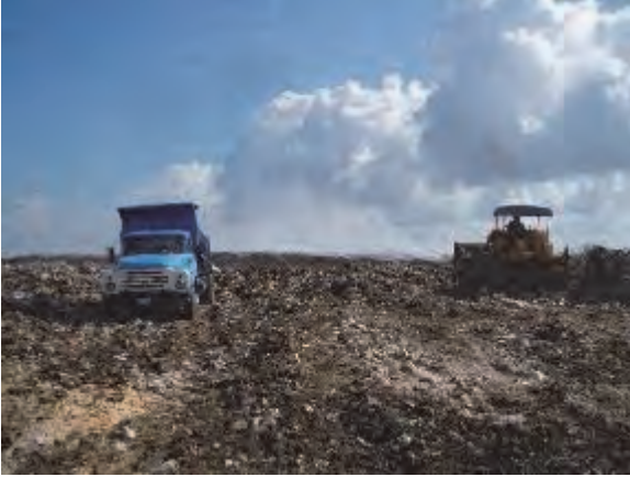
إعداد أرضية المطرح بواسطة الجرافة وتفرغ النفايات عند سفح المطرح
