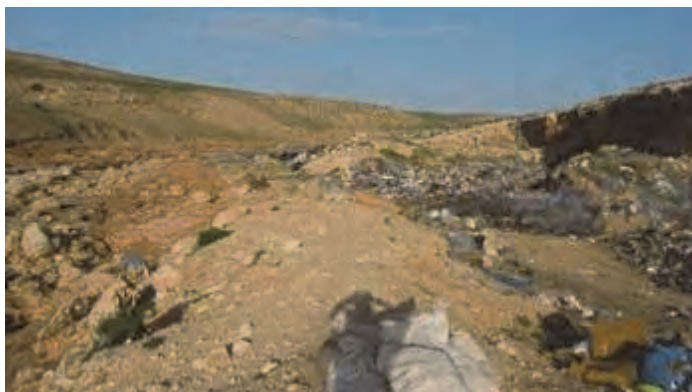
2014年11月大雨洪水に全ての廃棄物が流出したと想定される河道側斜面（写真左側斜面） （2015年1月撮影）
