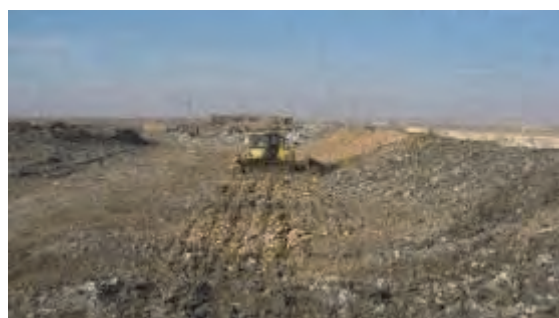
法尻近くの現地盤を掘削して覆土材を調達
