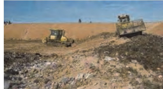
ピット奥左側エリアの転圧覆土作業
