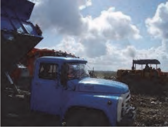
4 عربات لتفرغ النفايات عند سفح المنحدر. (بإمكان الجرافة أن تُسوي النفايات وتضغطها بطريقة فعالة على مسافة صغيرة)
