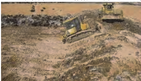
ピット奥右側エリアの転圧覆土作業 上の2図が隔日交互作業となる。
