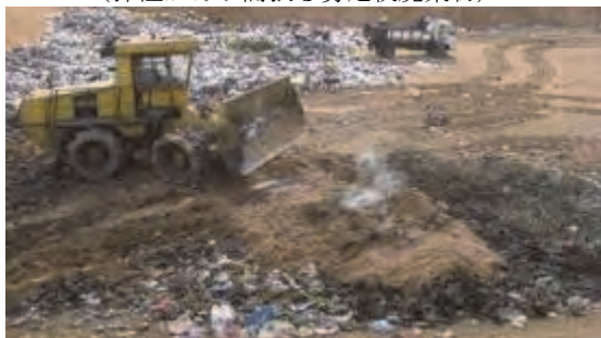
火種を含む廃棄物を隔離し覆土により消火
