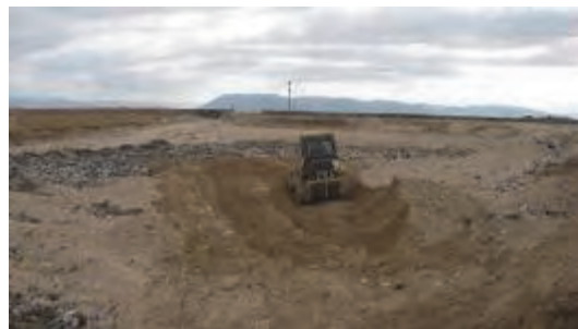
湛水排除のため除去した堰堤部分の隣の一角を掘削しての天盤覆土の拡大。
