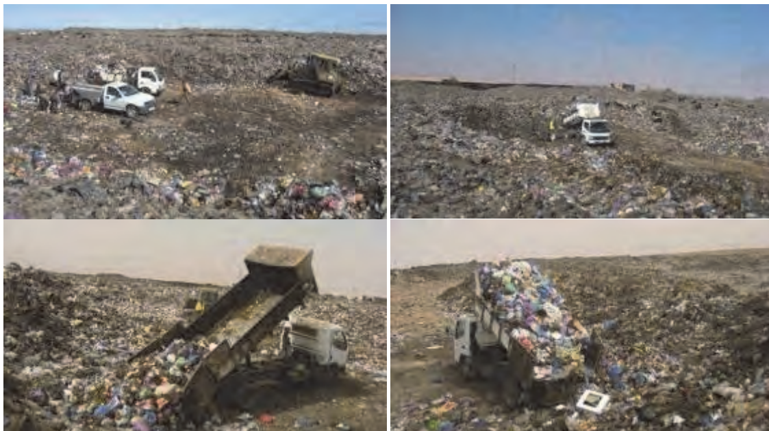
法尻近くにディスチャージする車両と誘導するスーパーバイザーMr. Arhil Abdelhadi
