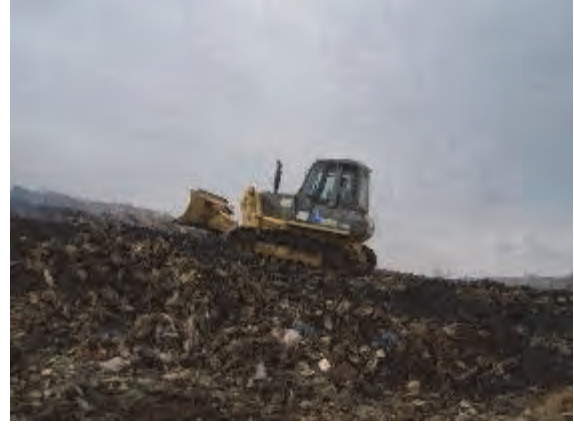
أشغال ضغط النفايات جارية فوق المنحدر (شفرة القطع لم تستعمل)
