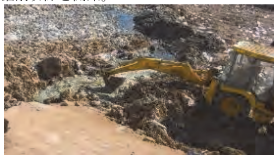
堰堤の一部を掘削除去し湛水排除を開始。その後、湛水エリアを順次狭める。
