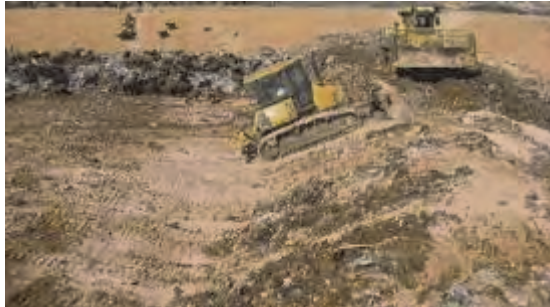
ピット奥右側エリアの転圧覆土作業 上の2図が隔日交互作業となる。
