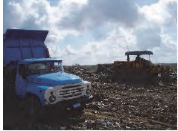
إعداد أرضية المطرح بواسطة الجرافة وتفرغ النفايات عند سفح المطرح
