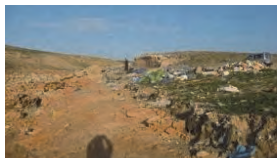
↑洪水時水位上昇に河道側斜面の廃棄物が流出し斜面岩地が露出
