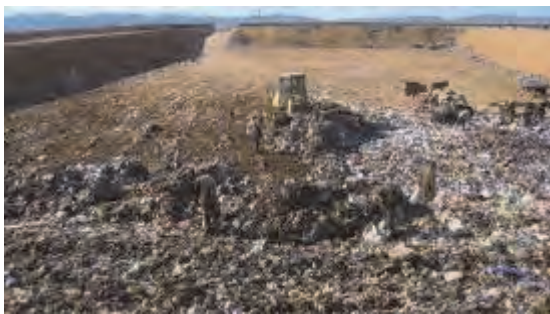
ピット奥右側エリアの敷均し作業
