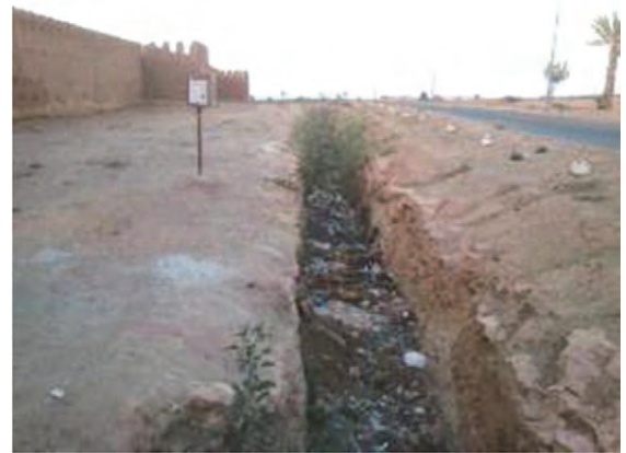
写真 5-4: 不法投棄禁止看板（左側）と不法投棄防止用石積み（右側）
