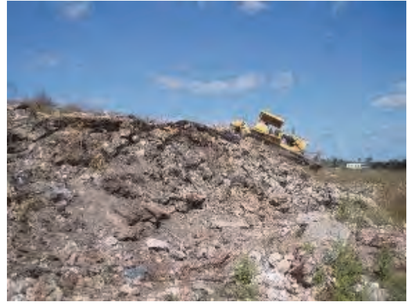
تسوية النفايات بالمنحدر الذي يعرف انتشار الحُفر المُشتعلة ثم الضغط عليها
