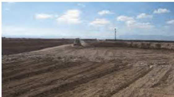
入口手前側エリアの一段目の天盤覆土の大半が完了 (奥側から入口方向を見る。) (入口から堰堤除去部方向を見る)
