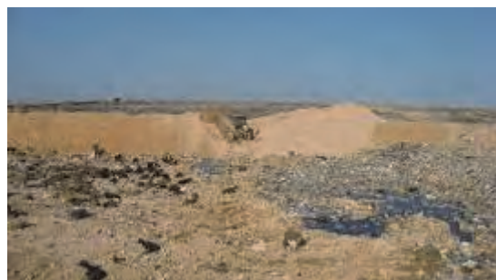
周回堰堤の一部を掘削切除を開始。
