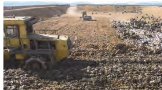
ピット内の埋立済みエリアの天盤転圧作業
