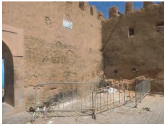
写真 5-5: 看板の設置と不法投棄防止用フェンス
