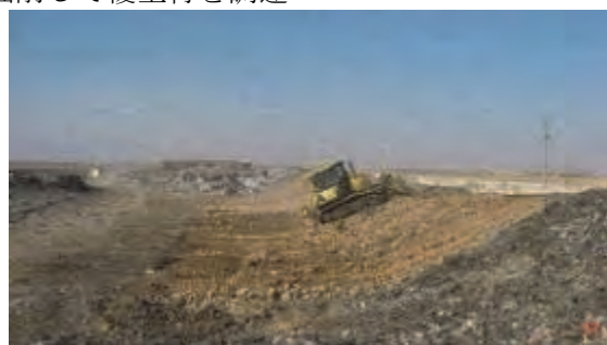
法尻近くの現地盤を掘削して覆土材を調達
