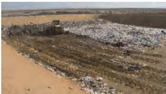
ピット奥左側エリアの敷均し作業
