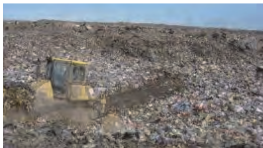
ドーザー板を用いての敷均し作業
