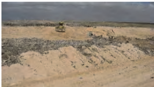
湛水排除のため除去した堰堤部分の隣の一角を掘削しての天盤覆土の拡大。
