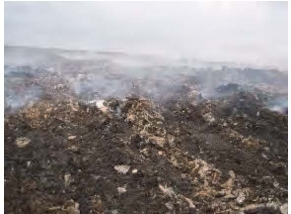
إطفاء الحريق عبر توزيع النفايات القديمة وضغطها. (النصف التحتي للصورة)
