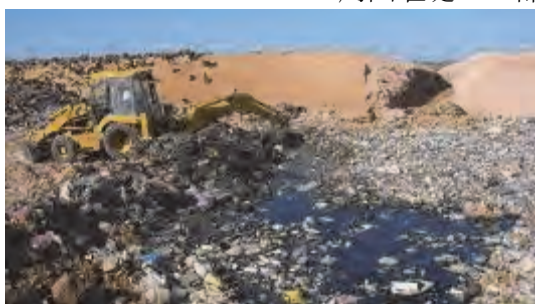
堰堤の一部を掘削除去し湛水排除を開始。その後、湛水エリアを順次狭める。
