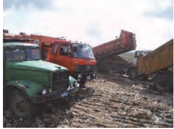
4 عربات لتفرغ النفايات عند سفح المنحدر. (بإمكان الجرافة أن تُسوي النفايات وتضغطها بطريقة فعالة على مسافة صغيرة)
