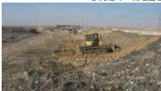
法尻近くの現地盤を掘削して覆土材を調達
