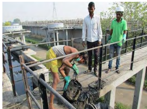
アグラ 78MLD の下水処理場 UASB-DHS システム UASB の汚泥除去作業 (2015 年 10 月 27 日)
