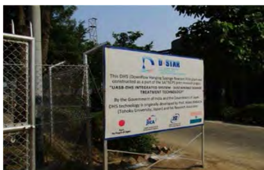
アグラ 78MLD の下水処理場 UASB-DHS システムの入口 (2015 年 10 月 27 日)
