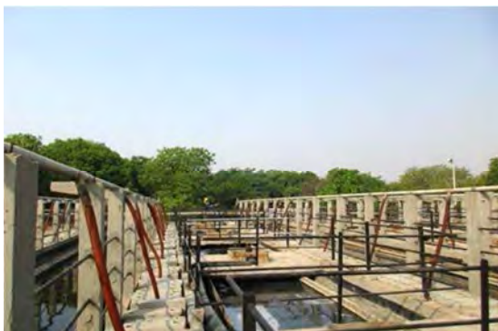
アグラ 78MLD の下水処理場 上昇流嫌気性汚泥床-下降流懸垂型ス ポンジ (UASB-DHS) システムの UASB (2015 年 10 月 27 日)
