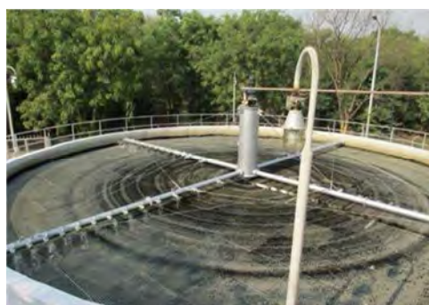
アグラ 78MLD の下水処理場 UASB-DHS システムの DHS プラント (2015 年 10 月 27 日)
