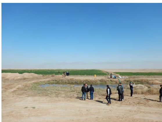
地区末端部でのポンプ灌漑 (ミサーン県)
