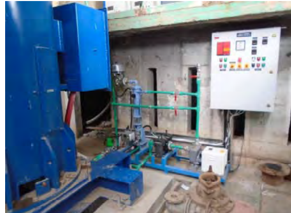
Badra Jassan No. 2 灌漑ポンプ場 新規ポンプ原動機の据付と配電盤の設置
