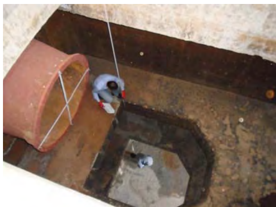
East Gharraf 灌漑排水ポンプ場 既存ポンプピットの測量
