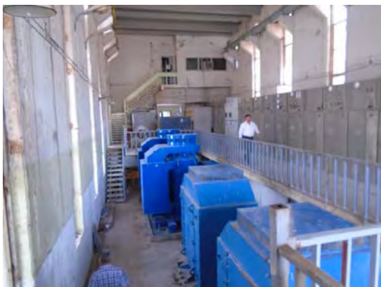
Badra Jassan No. 4 灌漑ポンプ場 新規ポンプ原動機の据付
