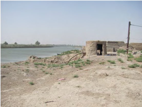
農家保有の小型ポンプ施設 (ディカール県)
