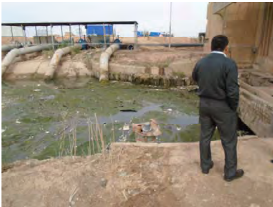
Badra Jassan No. 2 灌漑ポンプ場 既存吸水ピットの状況
