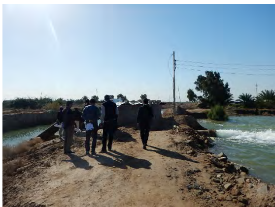
既存の簡易ポンプ施設 (ミサーン県)
