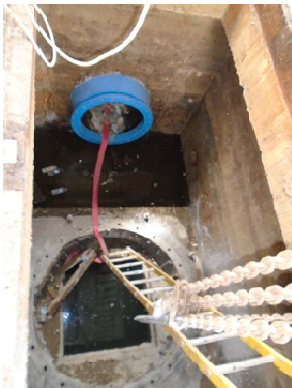
Shakha No. 10 排水ポンプ場 ポンプ底板の整備
