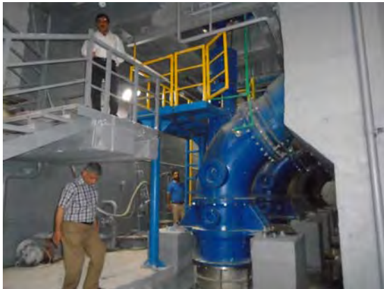
Badra Jassan No. 1 灌漑ポンプ場 新規ポンプの据付
