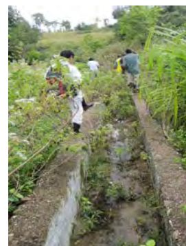
写真 建設された水路
