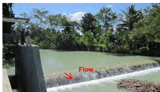
写真 頭首工の状況(雨期)
