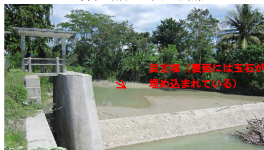
写真 頭首工の状況(乾期)
