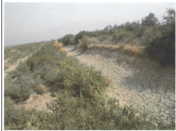
Piet Ghzayel WUA 灌漑2次水路の状況。傾斜地の上方側に土水路を設置 している。管理状態は良い。(Basrah 県)
