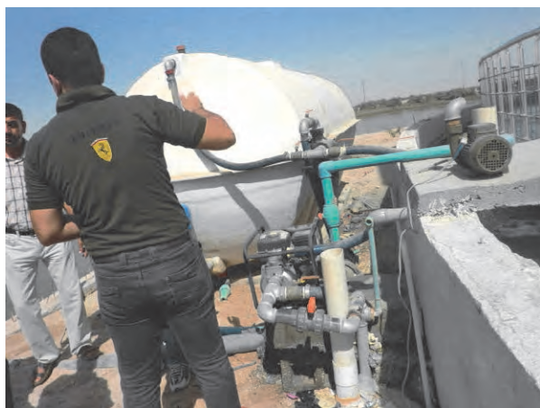
Al Manthori WUA 個人所有の点滴灌漑施設。写真は小規模水槽、加圧ポンプ (Basrah 県)
