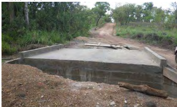
(2) ポートロコ県 Lot 2 の施工状況：完成直後のボックスカルバート。（2014 年 6 月）
