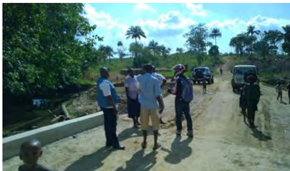
(1) カンビア県の施工状況：KDC 職員、SLRA エンジニアが施工業者へ指示を行う。（2014 年 6 月）
