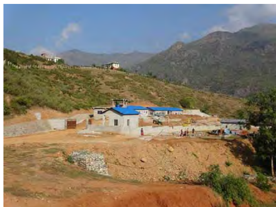
建設中のラムタール維持管理事務所
