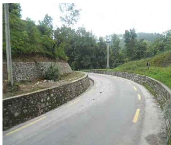
視線誘導の為の車線マーキング
