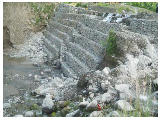
大規模修復維持管理 (Specific Maintenance)
