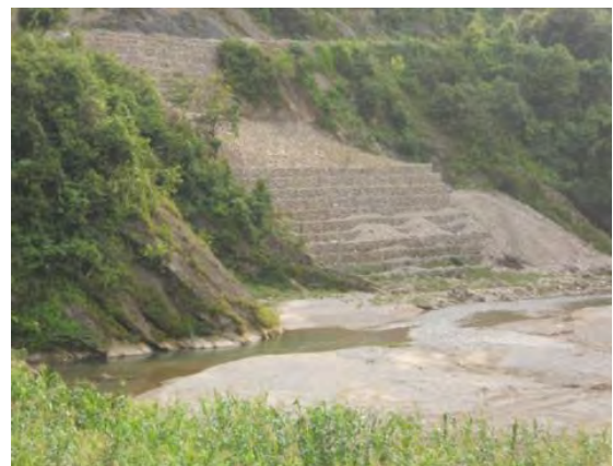
盛土部の河川浸食防止対策
