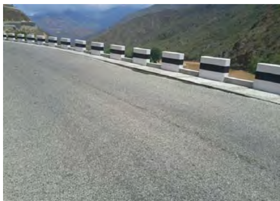
高盛土擁壁区間に設置した コンクリートガードブロック
