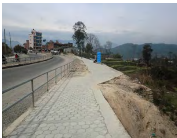
交通量の多い区間での歩道設置
