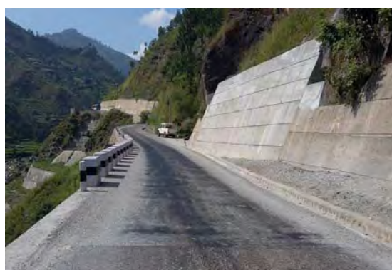
擁壁背面に落石用のキャッチ場を設けての 斜面擁壁設置
