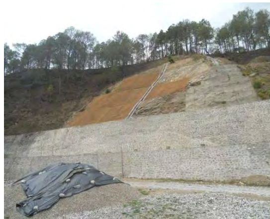
法勾配修正と排水工設置（修復後）
