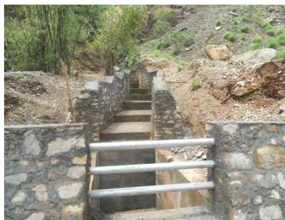
砂防ダム及び流水路設置（修復後）
