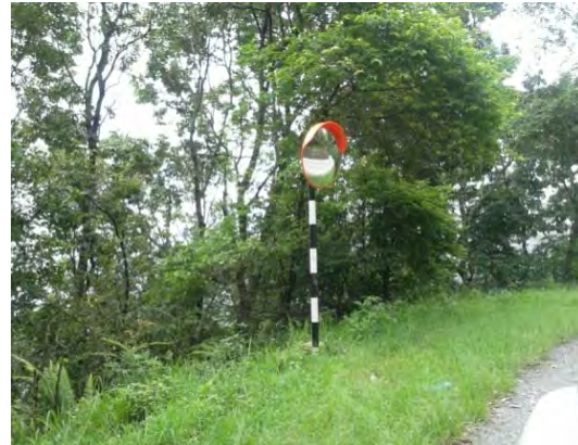
急カーブにおけるカーブミラーの設置
