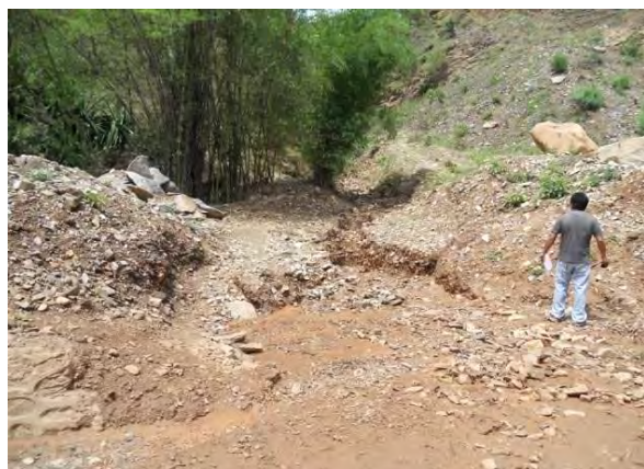
土石流発生箇所（修復前）
