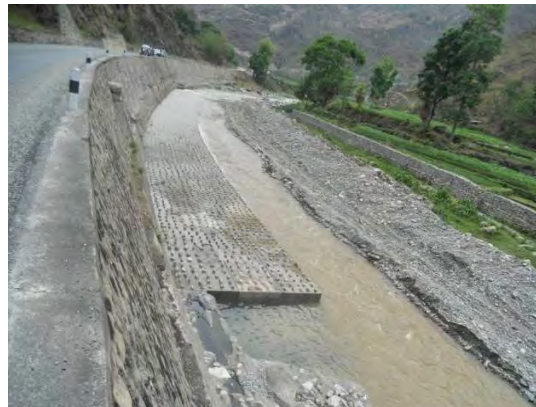
コンクリートブロック工の設置（修復後）
