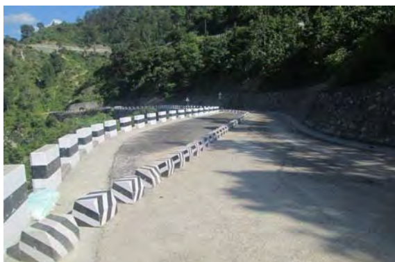
クラック部止水のためにアスファルト乳剤を充填
