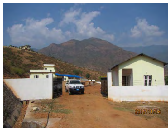
完成したラムタール維持管理事務所
