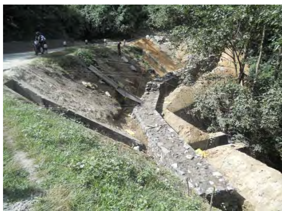
大規模修復維持管理 (Specific Maintenance)
