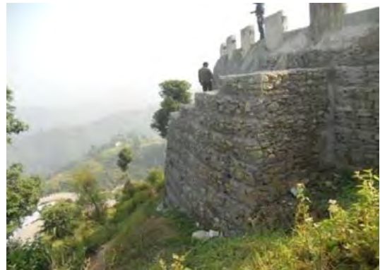
盛土側ギャビオン擁壁の膨らみ対策
