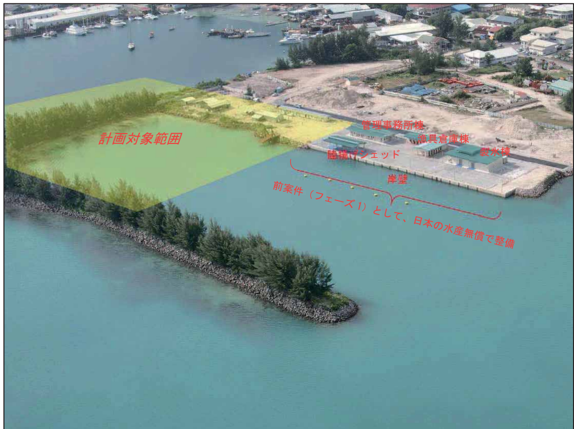
「前フェーズ工事竣工時の写真 (2010年2月) より」 計画サイトの航空写真
