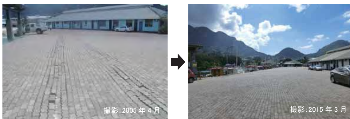
図2-1-4(7) ビクトリア漁港のインターロッキング舗装補修状況(SFA岸壁背後)
