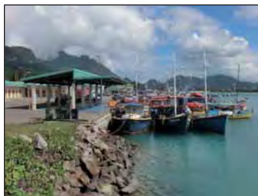
写真-5 陸揚げ岸壁
