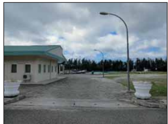
写真-36 計画地への既存エントランス
