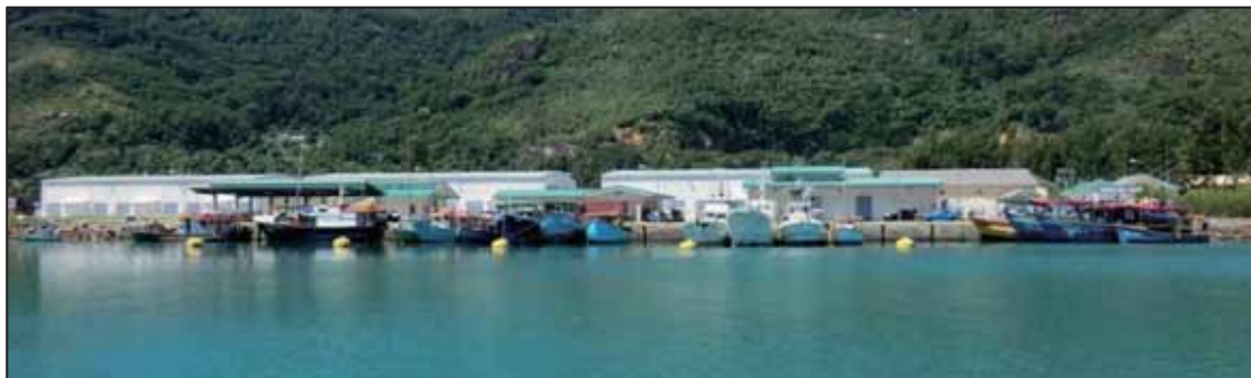
写真-1 プロビデンス漁港全景写真
