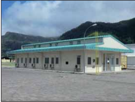
写真-8 管理事務所棟
