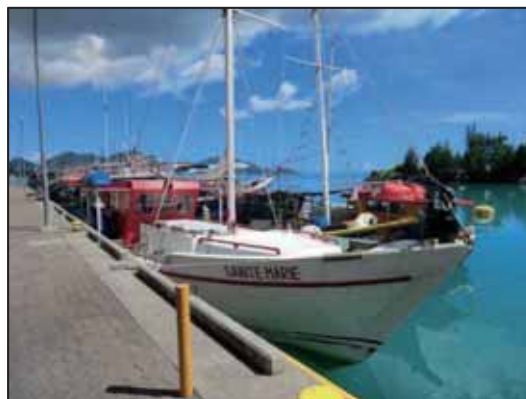
写真-3 準備岸壁（氷積み込み用）
