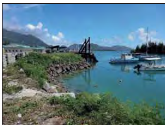
写真-25 岸壁-1 予定地の水際線
