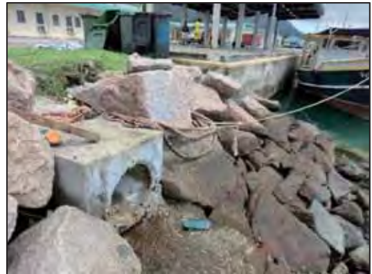
写真-34 岸壁-1 予定地の既存排水路
