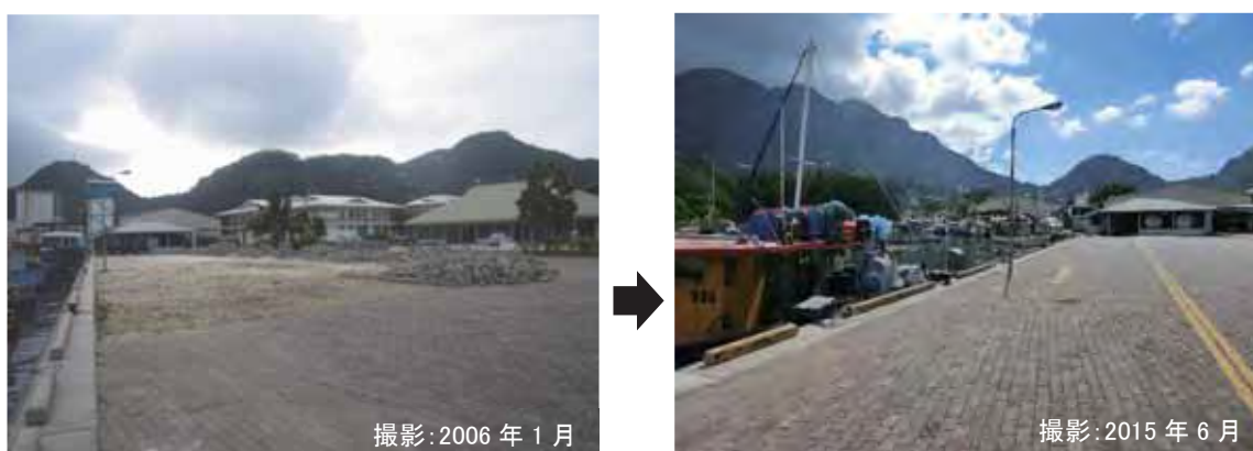
図2-1-4(8) ビクトリア漁港岸壁背後エプロン補修状況(SFA岸壁背後)
