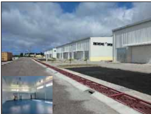
写真-35 計画地背後の既存水産加工場
