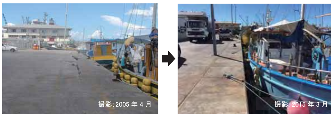
図2-1-4(6) ビクトリア漁港岸壁補修状況(オセアナ社前面)
