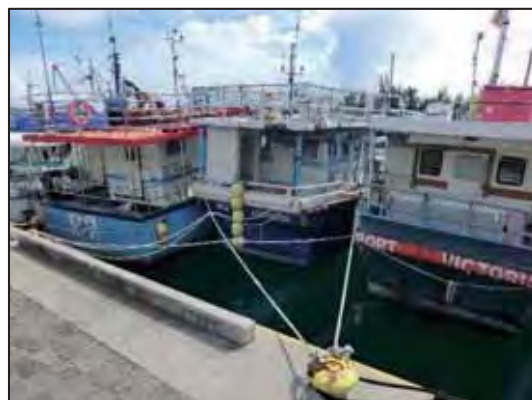
写真-4 係留岸壁
