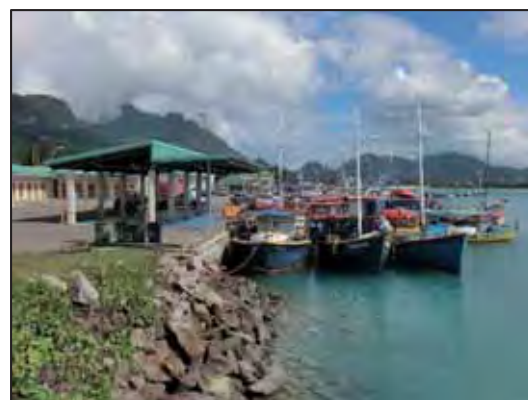
写真-5 陸揚げ岸壁
