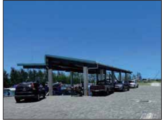
写真-9 陸揚げシェッド
