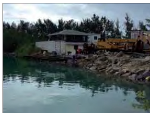
写真-26 岸壁-2 既存加工用地前面の状況
