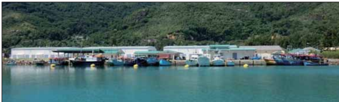
写真-1 プロビデンス漁港全景写真
