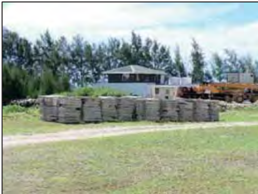
写真-33 既存加工用地周辺のブロック
