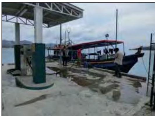
写真-2 給油岸壁
