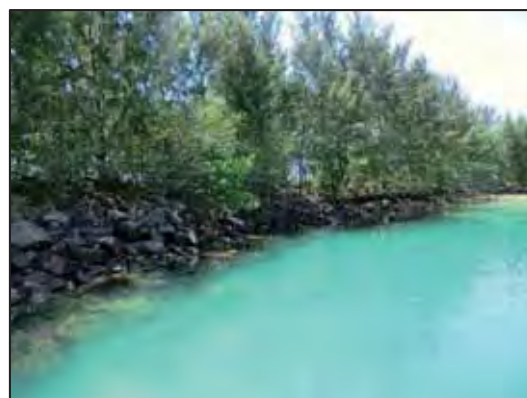
写真-28 岸壁-3 予定地の水際線
