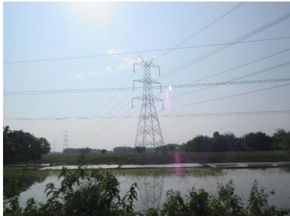
Existing 400kV AC T/L
