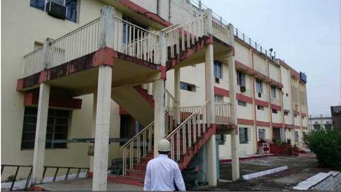
図 2-19 制御室外観 (Jabalpur 220kV 変電所)
