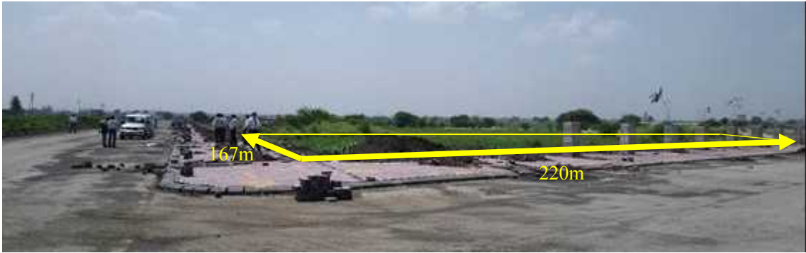
图 2-28 Super Corridor 变電所用地写真
