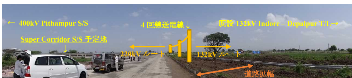
図 2-32 Super Corridor 変電所付近の送電線ルート
