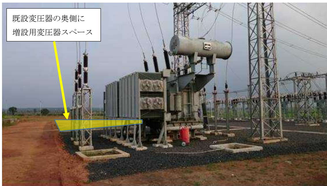
図 2-33 Tejgarh 変電所変圧器増設スペース
