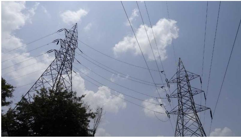
図 2-7 132kV LILO 送電線
