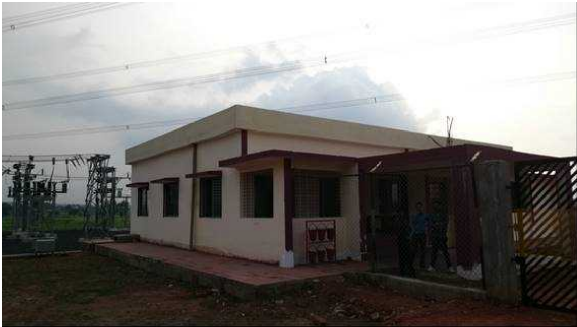
図 2-20 制御室外観 (Tejgarh 132kV 変電所)
