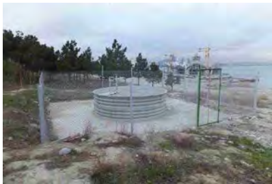
写真 8.4 集水井の状況
