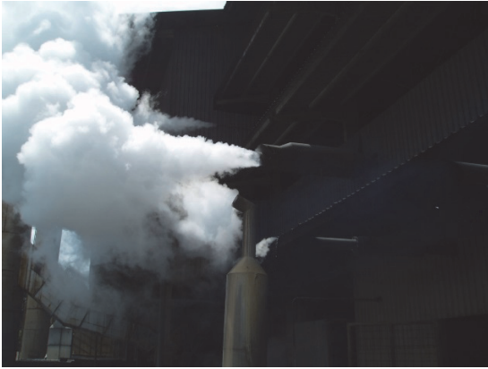
パーム油搾油工場から排出される蒸気
