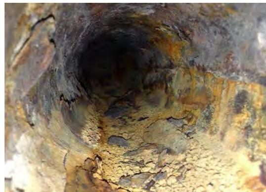
送水管(白ガス管)内部。腐食が進んでいる。
