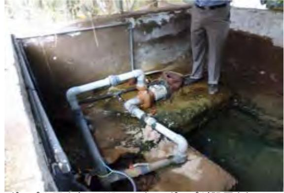
ポンプ小屋内部。引込み用加圧ポンプが設置されている。
