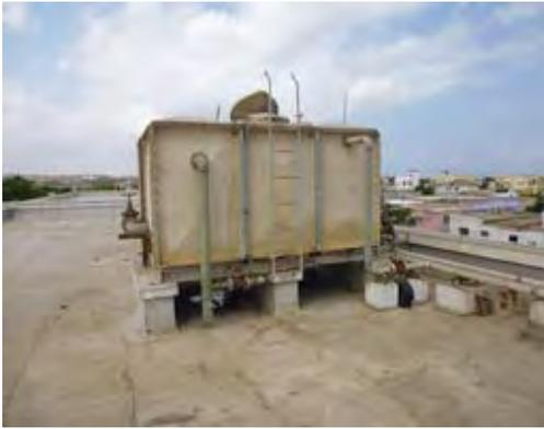
FRP製屋上貯水槽。劣化によりパネルが変色している。
