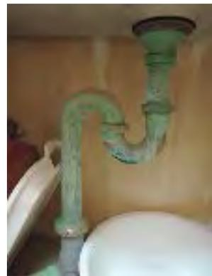
教員用シンクのSトラップ。薬品/塩分により腐食している。
