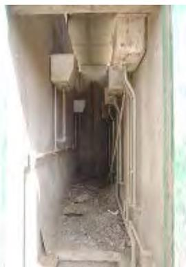
便所棟ピット室内部。床に穴が空けられている。手前は掃除用開口。
