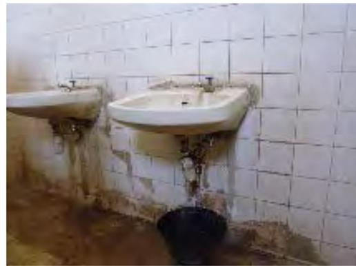
管理棟男子便所。取付が不安定になっている。排水トラップは補修されているが漏水している。
