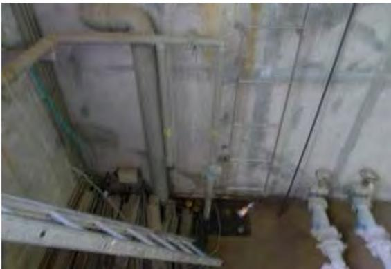
ポンプ室内釜場。排水ポンプが設置されている。
