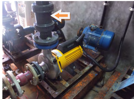
仮ポンプ配管：古い配管（左写真←）が PVC 管に交換された（右写真←）
