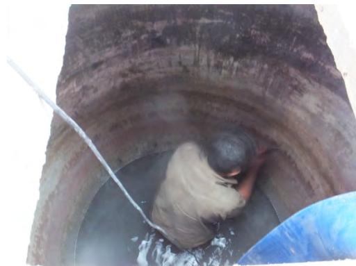
② 井戸底盤を破碎する工事
