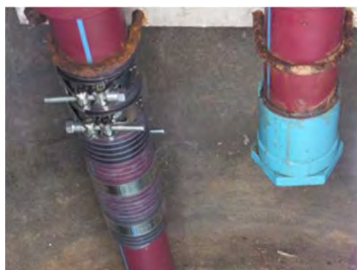
最終的に設置された仮の配管接続
