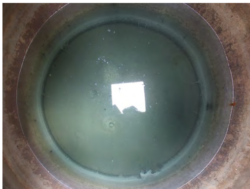
① 井戸底盤（取水開孔部は3箇所）
