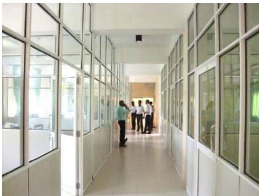
⑤職員室の各部屋(アルミ製の間仕切り)
