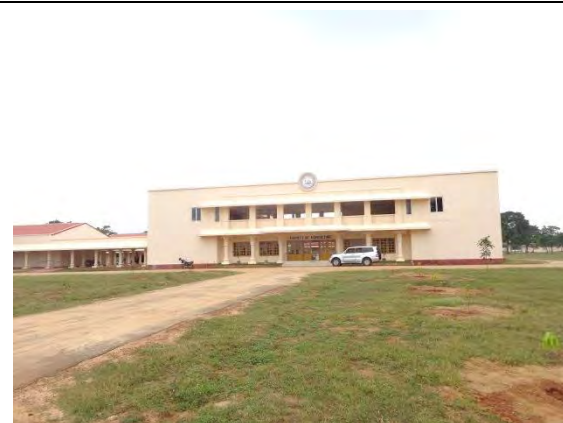
⑩ 農学部管理棟：学部長室、学部事務所他、現在は農業技術科、農業経済科が使用。
