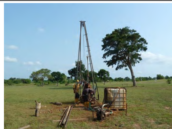
⑮ 研究棟建設予定地での地質調査の様子。
