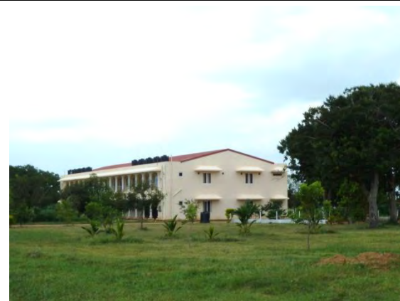
⑦ 学科講義棟 2：作物学科、畜産学科、農芸化学科。「ス」国政府予算で改修済み。
