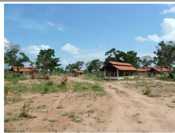
① 牛舎・鶏舎：WBの支援で建設し、建屋は完成しており、既に牛の飼育を開始している（右奥：牛舎、他：鶏舎）。
