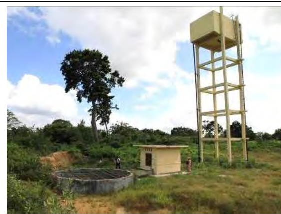
② ほ場内井戸と高架水槽：「ス」国側予算では場用に建設されたが、自然条件調査にて水量が不十分であることが確認された。
