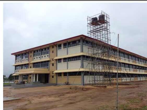
⑬ 工学部校舎：「ス」国政府の資金で建設した1棟が完成した（2015年11月）。
