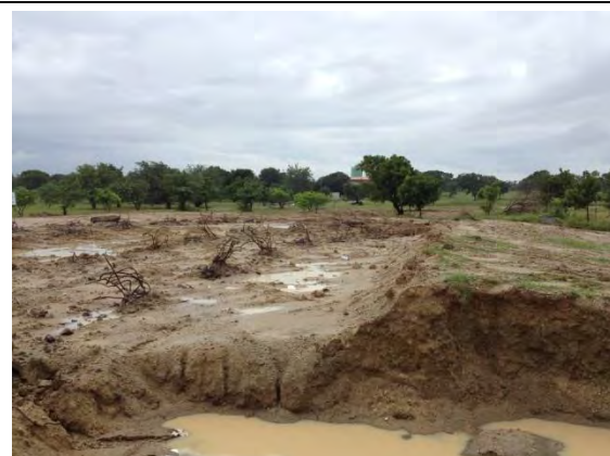
⑭ 講堂建設敷地：インド政府の支援による建設工事が開始された。
