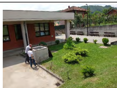
【FD-7】オイルタンク（芝生部分に埋設）と給油用ポンプ（コンクリート構造物）の位置。
