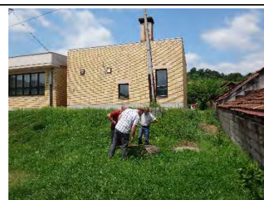
【FD-7】燃料漏れが疑われた際には、学校敷地内、ボイラー室裏の草が枯れたという。
