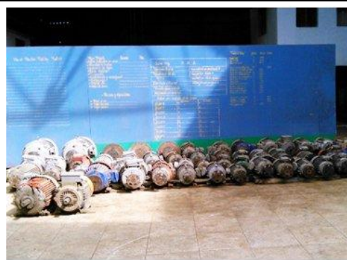
Motores en reparación
