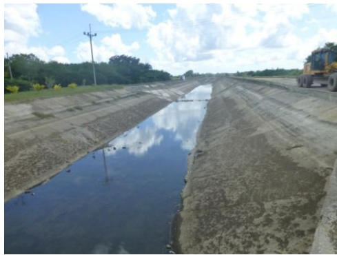
Central hidroeléctrica Zaza: Canal de irrigación
