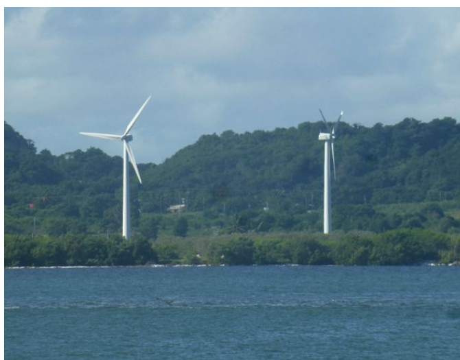
Figura 7.3.2-2 Unidad de generación eléctrica existente del parque eólico de Turiguano (250 kW×2unidades)
