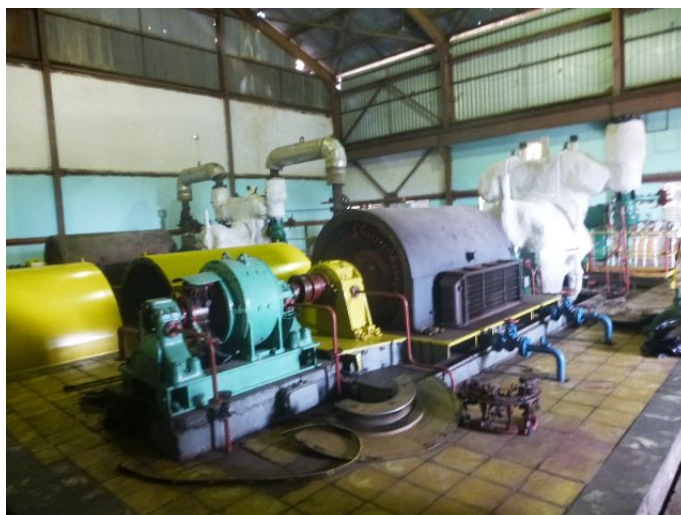
Figura 7.3.1-1 Instalaciones de generación eléctrica existente con bagazo (4 MW): Fábrica azucarera Panchito Gómez Toro, Provincia de Villa Clara
