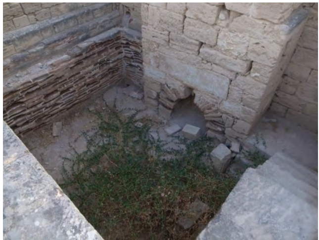
図 2-5 浴室の焚き口（南側）
