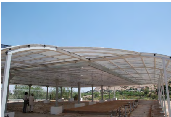
写真11 類似施設（ジェリコ郊外のシナゴグ） オープン型のシェルターで、スチールの軽快な構造と中空ポリカーボネートによる屋根、遺跡に配慮した置き基礎が特徴になっている。
