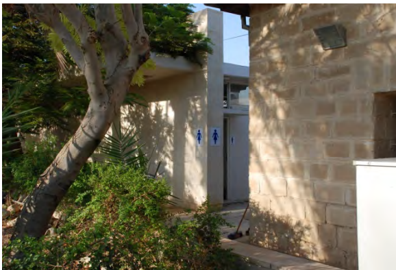
写真9 サイト内トイレ棟 USAIDの協力により整備されたトイレ棟。汚水は腐敗槽で処理したのち、地中浸透させている。
