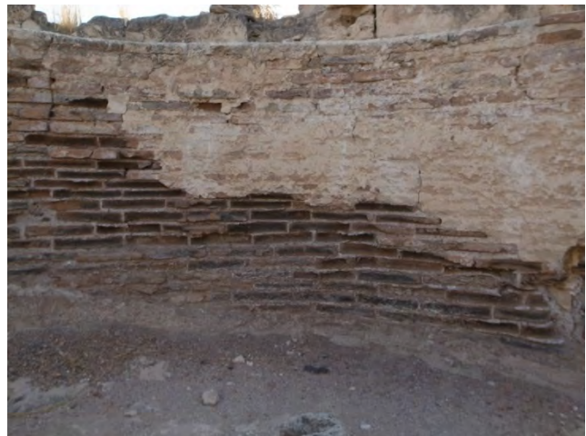
図 2-4 プールの煉瓦および漆喰壁
