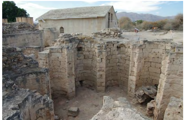
写真4 大浴場北側部分
